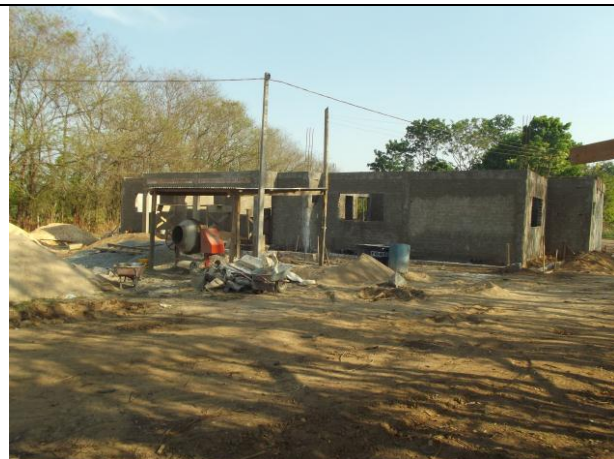
Figura 32: Construção Delegacia Paranaíta - MT.
