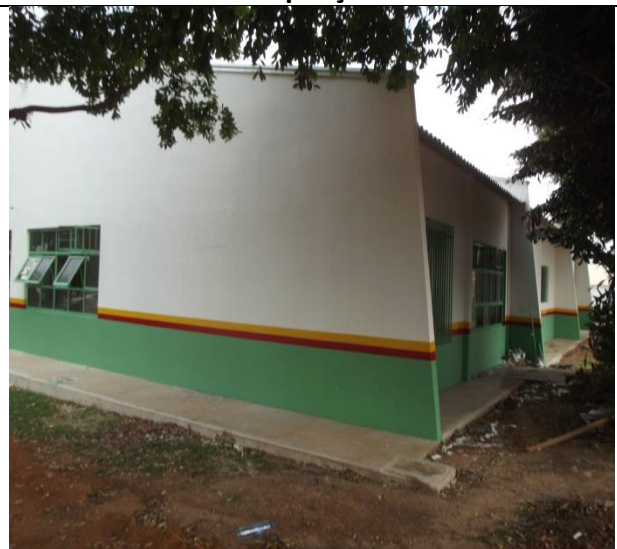
Figura 74: Reforma e ampliação prédio da SMS.
