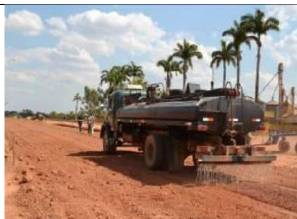
Figura 42: Início pavimentação Avenida Teles Pires.
