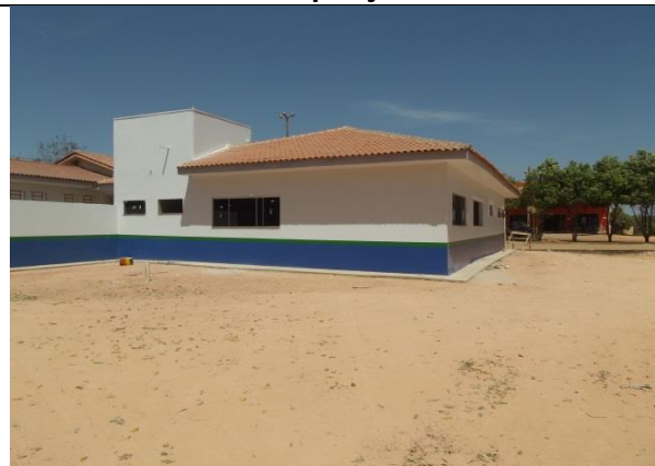
Figura 50: Reforma e ampliação PSF II.
