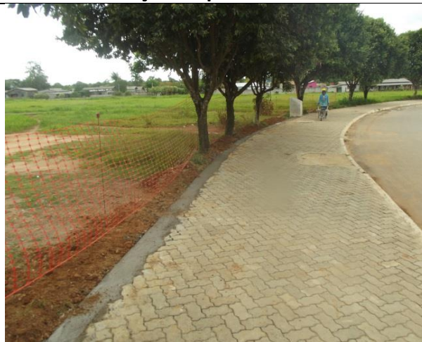
Figura 58: Construção Pista de Caminhada.
