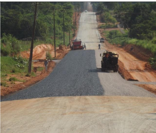
Figura 81: Execução da Pavimentação Avenida Teles Pires.
