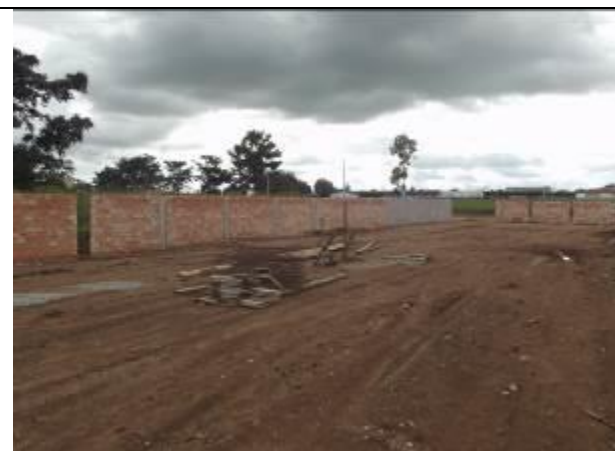
Figura 35: Construção Muro Delegacia Paranaíta - MT.
