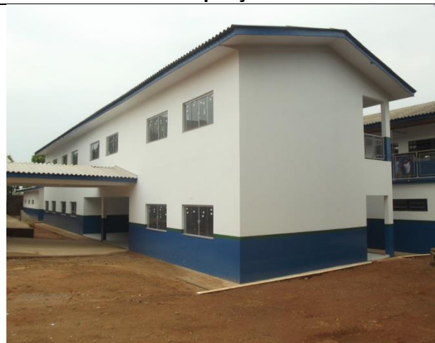
Figura 64: Reforma e ampliação Escolas Paranaíta – MT.
