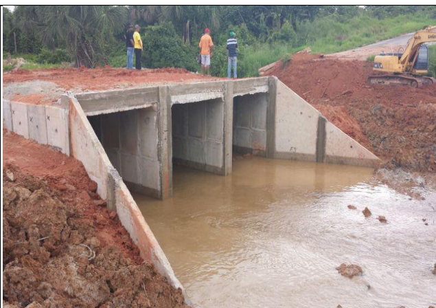
Figura 41: Construção Ponte Avenida Teles Pires.
