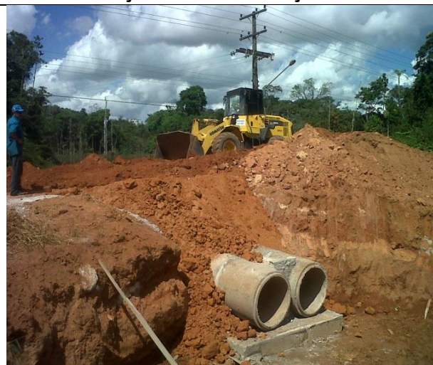
Figura 80: Execução da Pavimentação Avenida Teles Pires.
