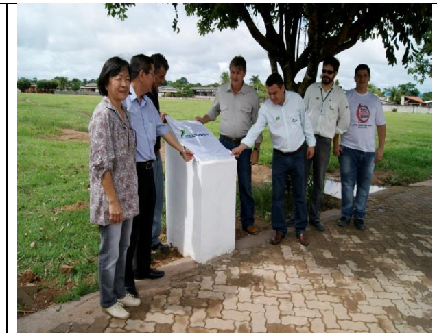
Figura 59: Construção Pista de Caminhada.
