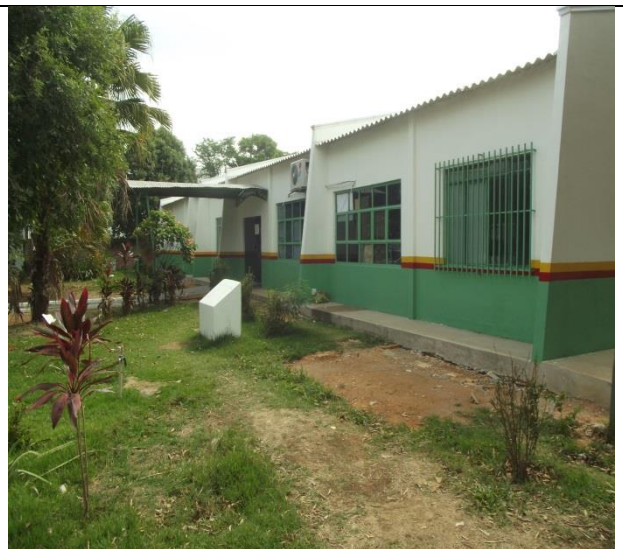
Figura 75: Reforma e ampliação prédio da SMS.
