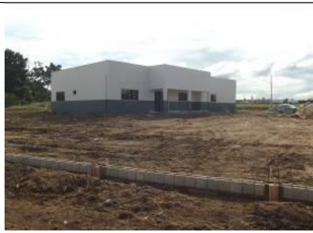
Figura 33: Construção Delegacia Paranaíta - MT.
