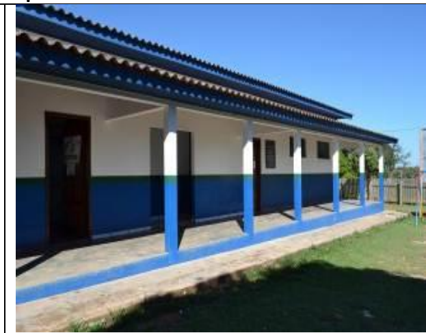
Figura 65: Reforma e ampliação Escolas Paranaíta – MT.
