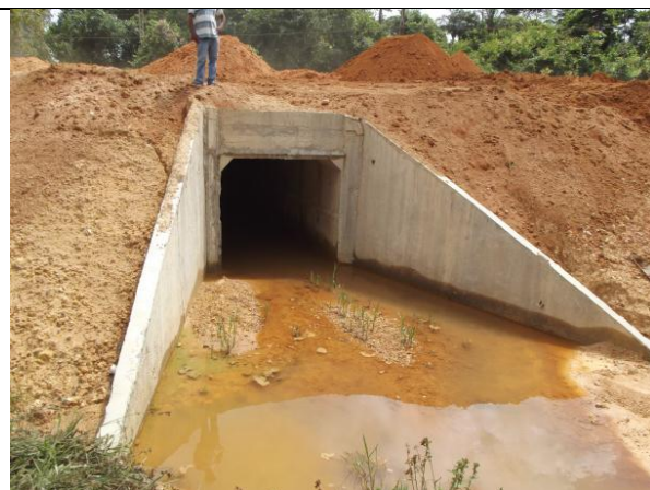
Figura 40: Entrega Ponte Avenida Teles Pires.
