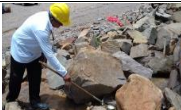
Figura 09: Captura forma imatura Anopheles Ponto 01 Canteiro de Obras.
