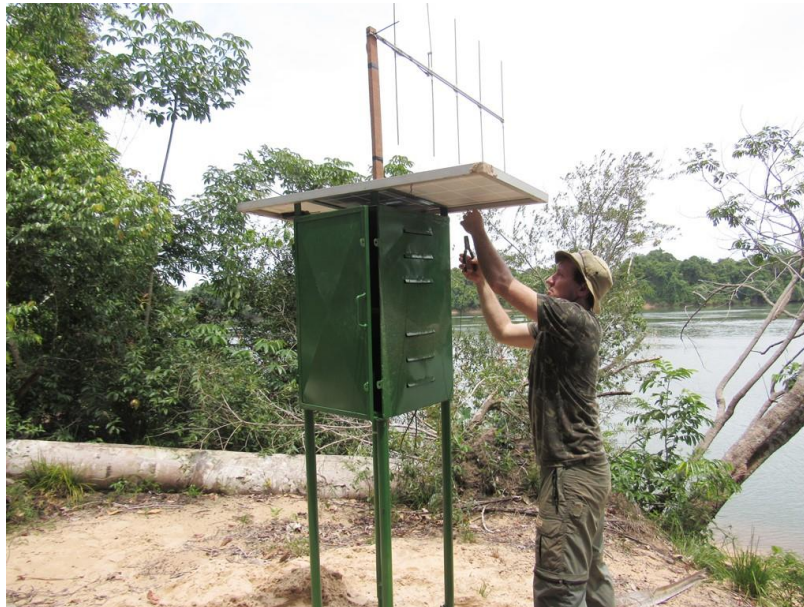
Figura 6 – Instalação de painel solar na base fixa de radiotelemetria da margem do rio Teles Pires.
