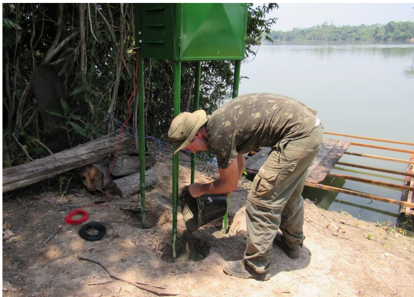
Figura 2 – Fixação no solo da base fixa de radiotelemetria da balsa do Cajueiro.
