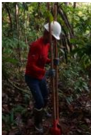
Foto 7. Abertura do poço utilizando cavadeira.
