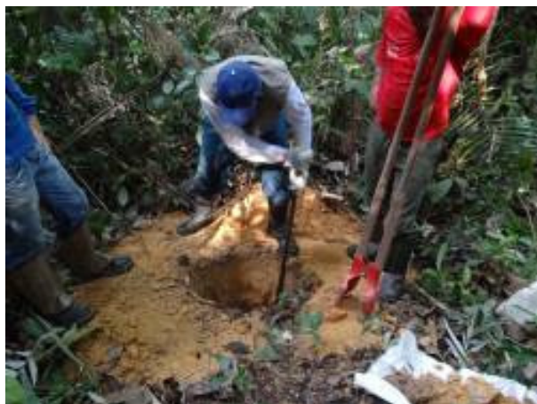
Foto 8. Abertura do poço utilizando cavadeira e alavanca.
