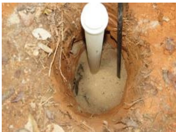
Foto 13. Cano de PVC colocado no poço mostrando detalhe de areia para filtro.
