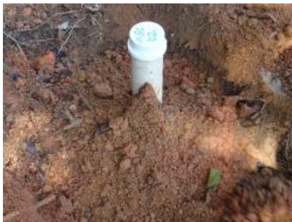
Foto 16. Finalização dos poços de monitoramento do lençol freático.
