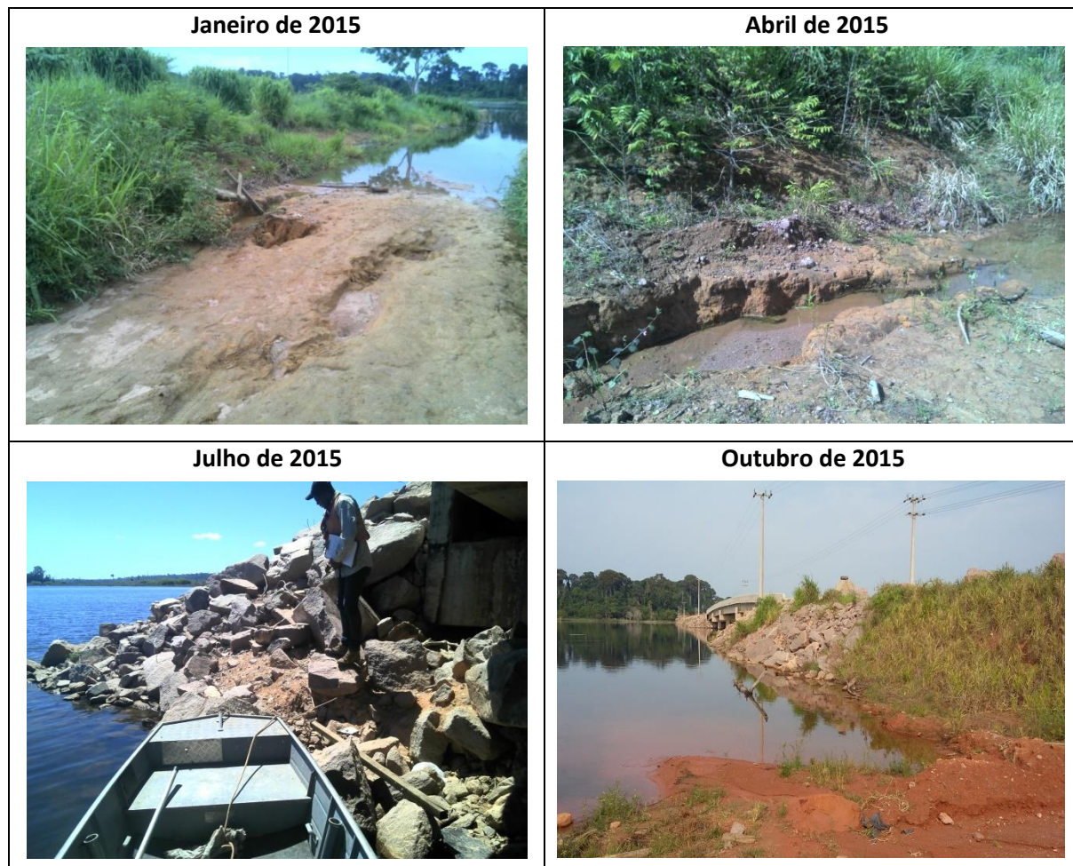
Figura 18. Ponto MD-23, localizado na nova ponte do rio Paranaíta.
