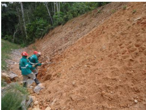
Escarificação de talude de corte em acesso provisório. Plantio de espécies forrageiras.
