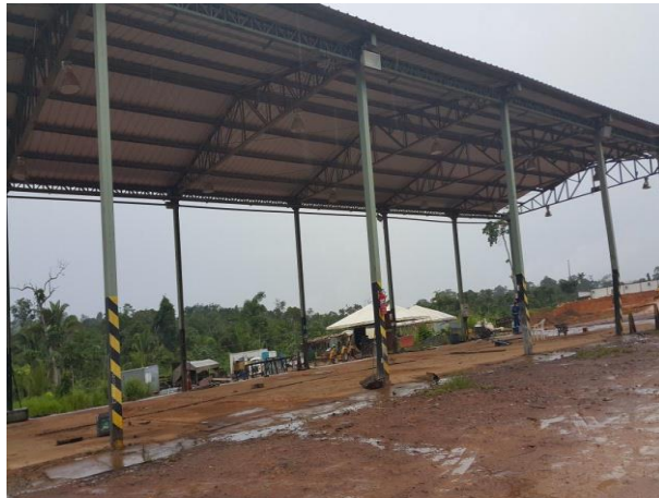
Área da antiga oficina do Pioneiro em processo de desmobilização.
