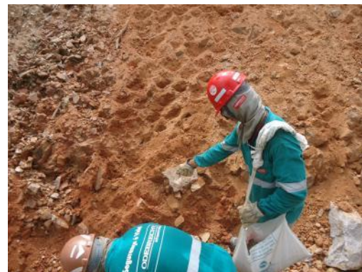
Escarificação de talude de corte em acesso provisório. Plantio de espécies forrageiras.
