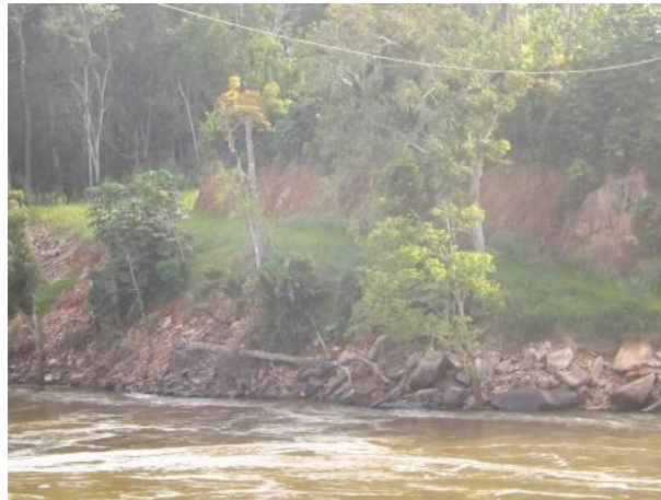
Acesso ao atracadouro na margem esquerda após as práticas de recuperação (Janeiro de 2014).
