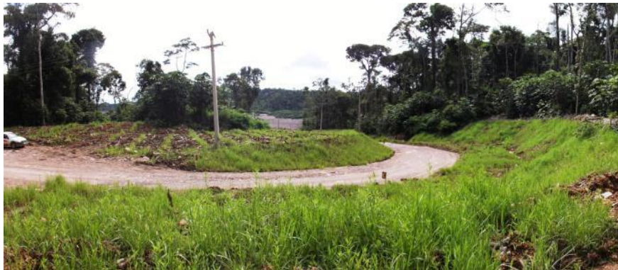
Área da oficina de terceiros da Margem Esquerda após a intervenção, em Fevereiro de 2014.
