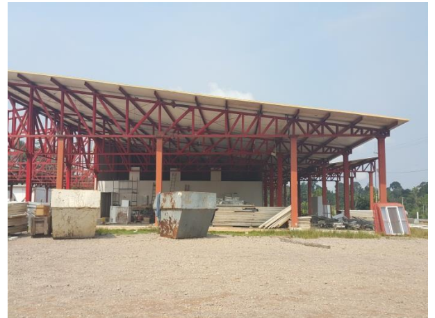
Antigo Refeitório ME em processo de desmobilização
