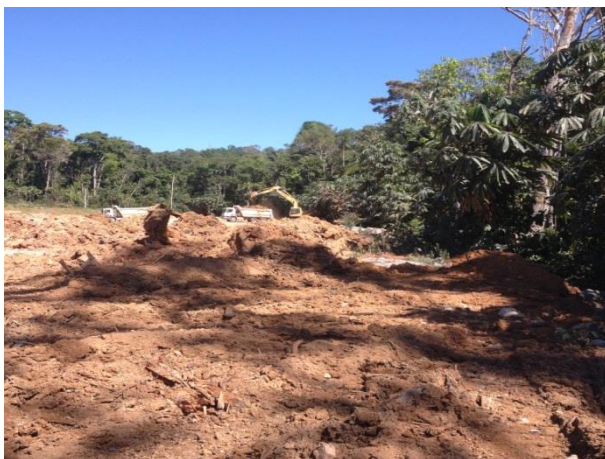
Escavadeira realizando o lançamento de material vegetal na área da antiga Carpintaria e Pátio de Formas.
