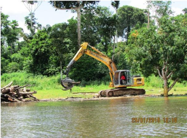
**Foto 05.** Retirada do material acumulado com uso de escavadeira hidráulica com pinça.
