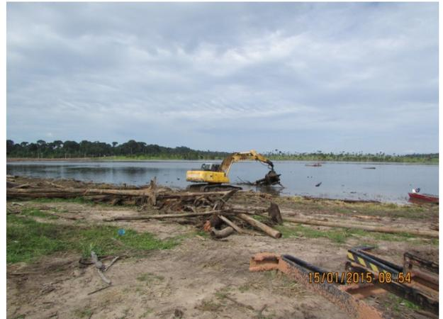
**Foto 06.** Retirada do material acumulado com uso de escavadeira hidráulica com pinça.
