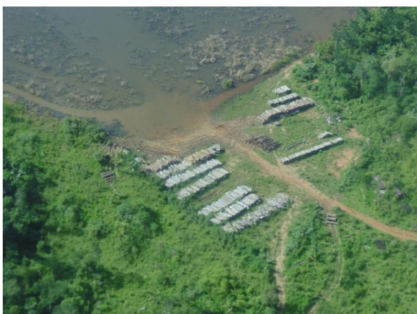
Foto 11. Vista aérea do pátio após o fim das atividades. (LOTE B2 – UHETP 36).
