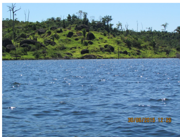
Foto 20. Vista parcial do reservatório após a retirada do material flutuante.
