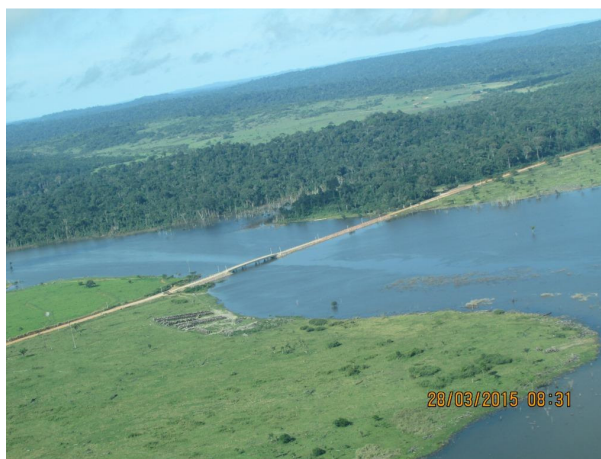
Foto 18. Vista parcial do reservatório após a retirada do material flutuante.
