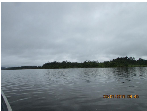
Foto 17. Vista parcial do reservatório após a retirada do material flutuante.
