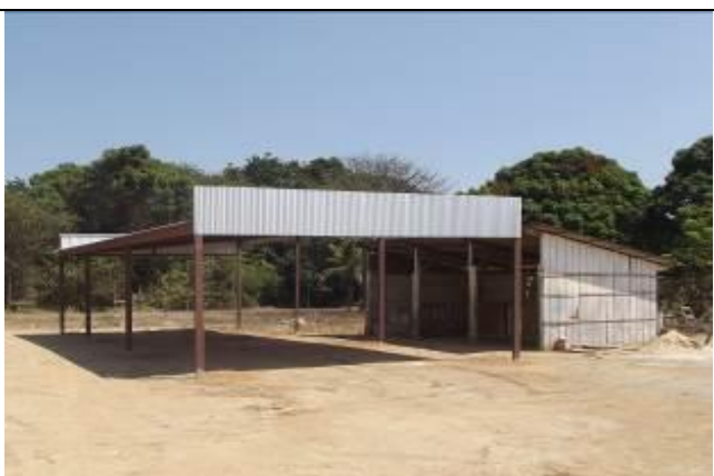
Figura 06: Garagem coberta em anexo ao Hospital municipal de Paranaíta – MT.
