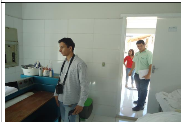
Figura 05: Vistoria final reforma Lavanderia com a participação do Engº Civil e Secretária Municipal de Saúde de Paranaíta.
