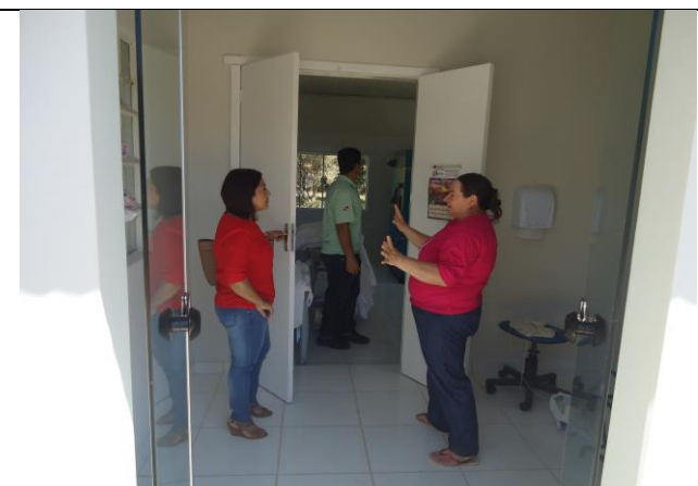
Figura 04: Vistoria final reforma Lavanderia com a participação do Engº Civil e Secretária Municipal de Saúde de Paranaíta.
