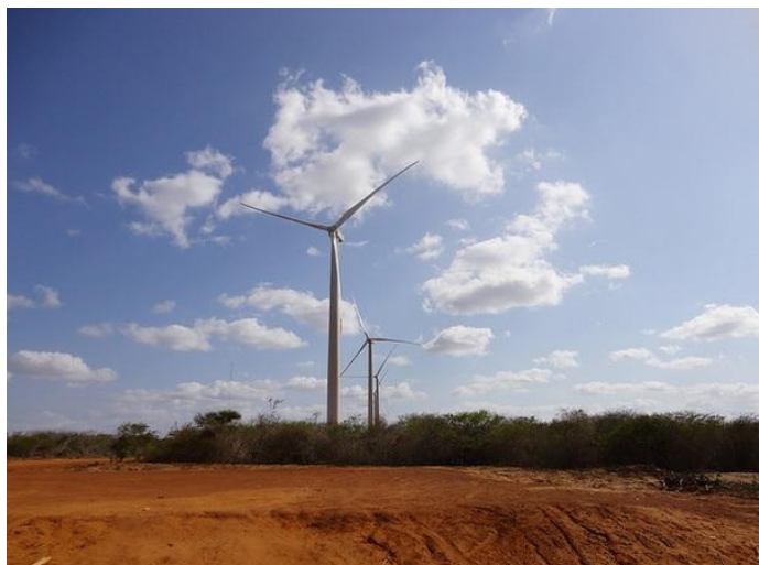
UEE em Morro dos Ventos, RN
