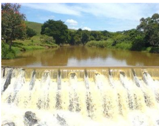
Ponte Queimada I, MG
