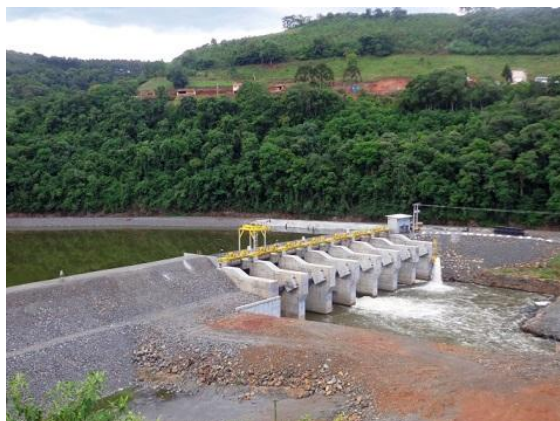
Pequena Central Hidrelétrica Salto Góes, SC
