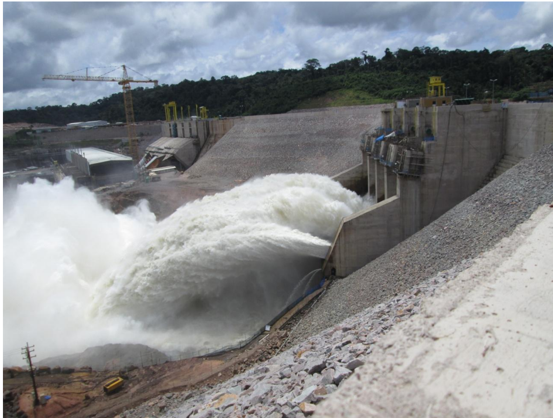
UHE Teles Pires – 1.820 MW – Mato Grosso/Pará
