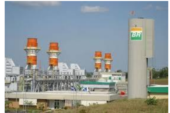
Usina Termoelétrica –Azulão, AM
