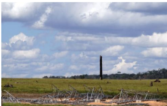
Vistoria de campo com registro fotográfico da LT no trecho Alta Floresta - Paranaíta
