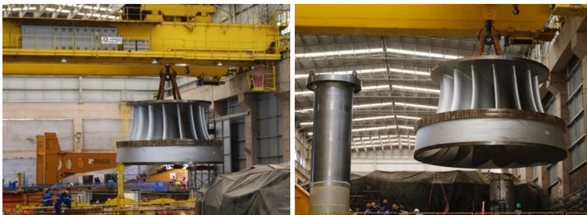
Descida do 4º rotor na área de montagem da UHE Teles Pires
