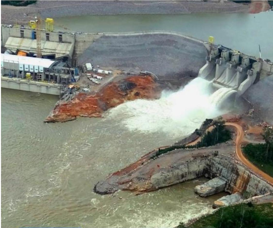
Vazão da água controlada pelo vertedouro marca processo de enchimento do reservatório da UHE Teles Pires
