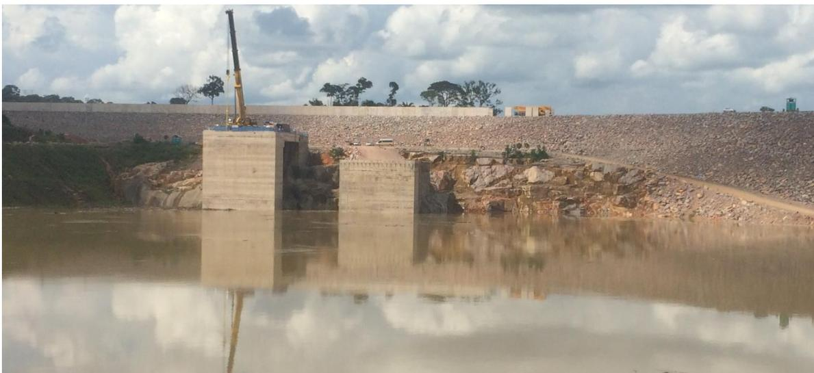
**Figura 3.2.** Estruturas de controle mostrando a estrutura do túnel 01 completamente encoberta após o fechamento do primeiro vão.
