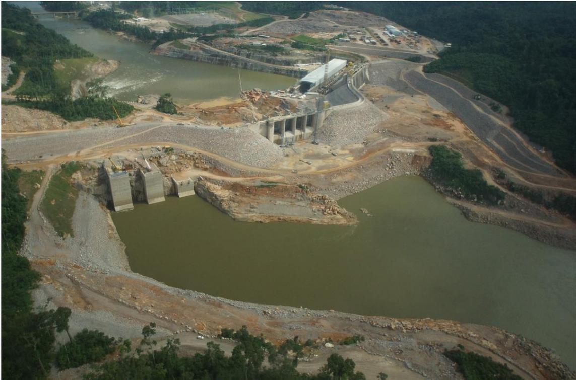
**Figura 2.1.** Imagem aérea do dia 10/12/2014 com NA 169,32 após o fechamento dos dois túneis de desvio.
