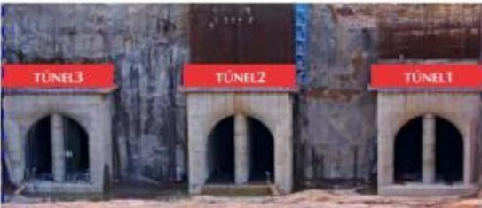
Túneis construídos para o desvio do rio e que serão fechados para o enchimento do reservatório.
