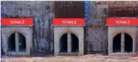
Túneis construídos para o desvio do rio e que serão fechados para o enchimento do reservatório.
