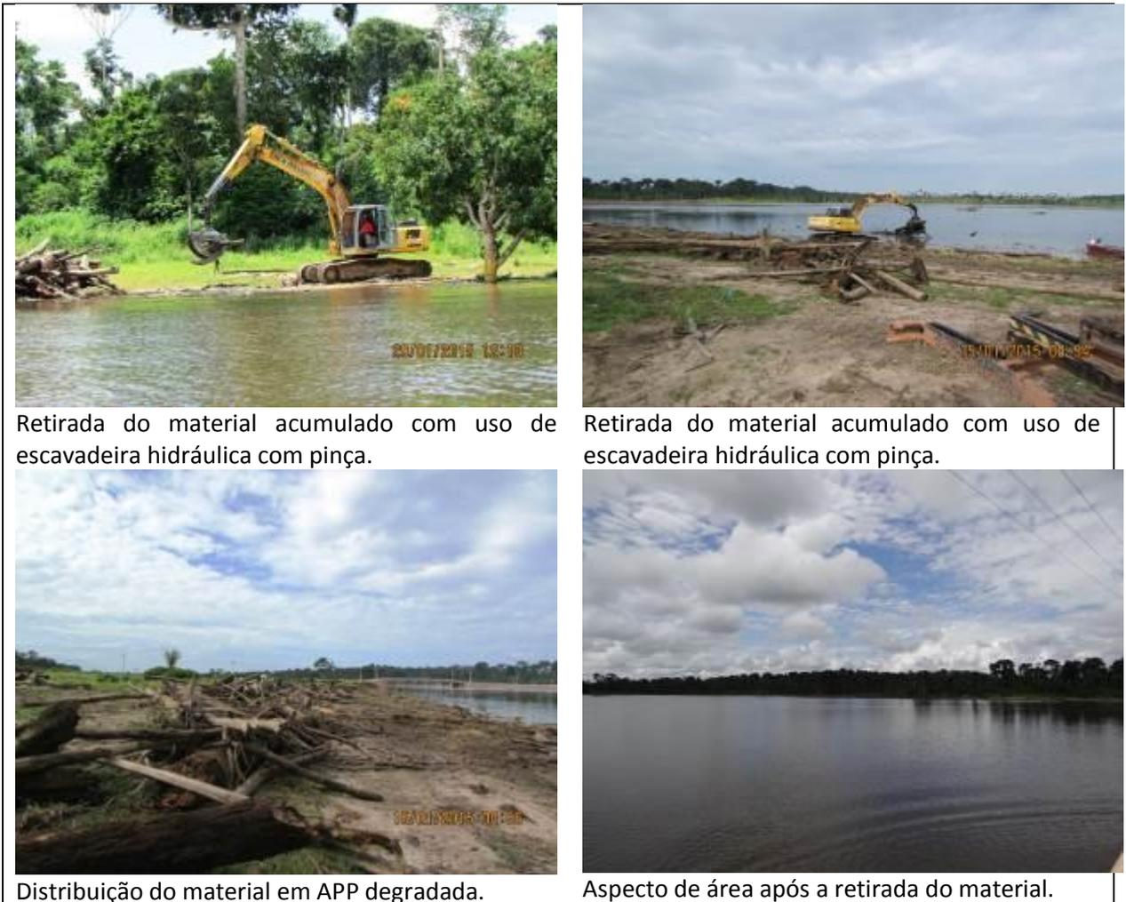
**Figura 4.1.** Retirada de material flutuante após o enchimento
