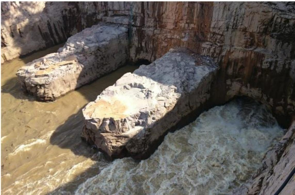
**Figura 2.2.** Saída da água pelo túnel 03 com os túneis 01 e 02 fechados.
