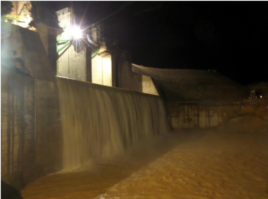
**Figura 3.3.** Registro Fotográfico da água iniciando o vertimento na elevação 198,80m.
