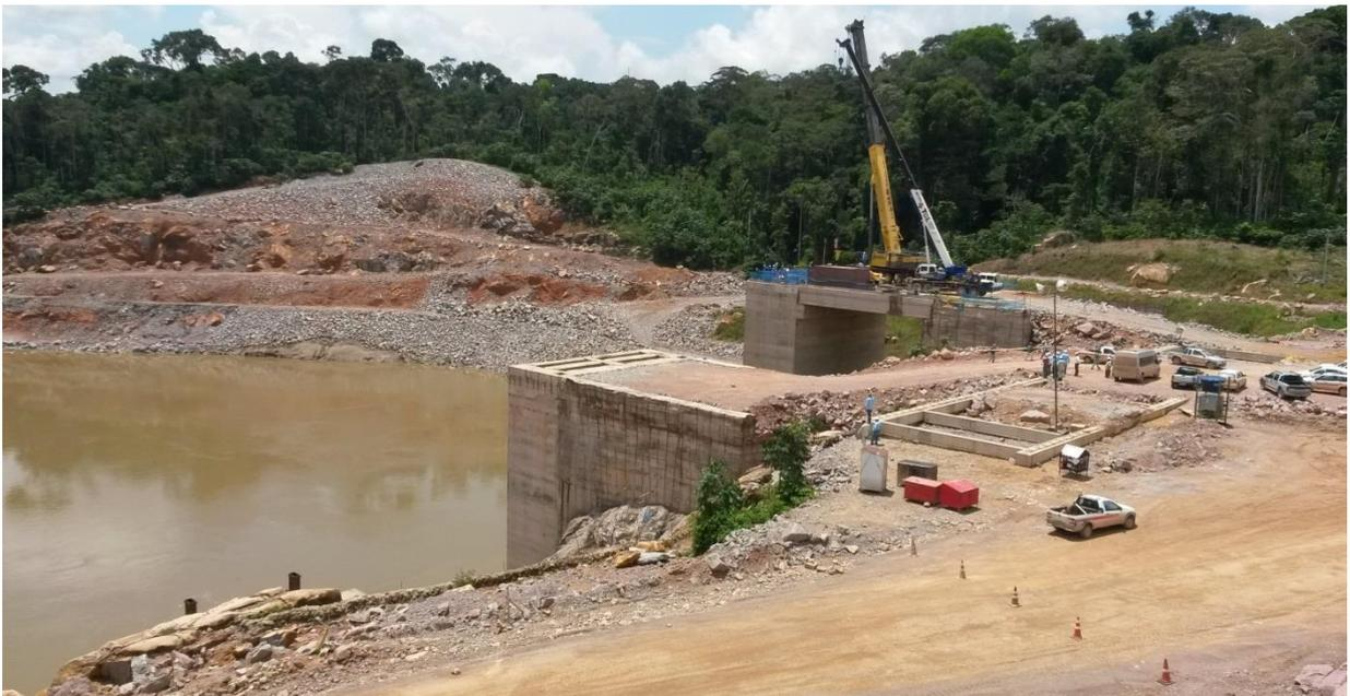
**Figura 3.1.** Guindaste posicionando na estrutura de controle para fechamento do primeiro vão do túnel 03 realizado no dia 14/12/2014, próximo das 12hrs.
