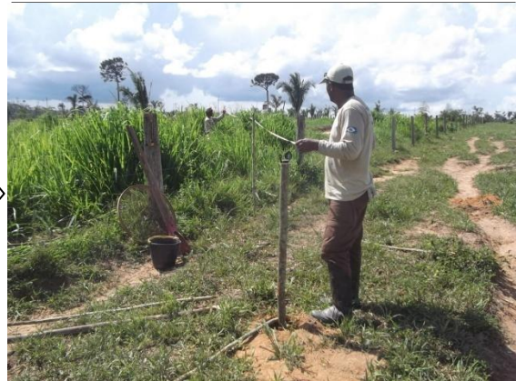
UHE Teles Pires. Equipe medindo distancia entre poço teste de radial.
