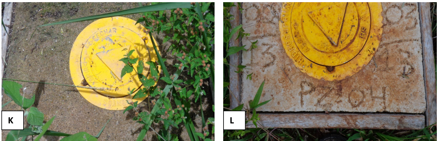
Figura 5 – Registro das leituras de nível realizadas nos Piezômetros localizados na área de influência da UHE Teles Pires. A = PZ04; B = preparando para descer a sonda; C = descendo o medidor; D = PZ09; E = abrindo a tampa do piezômetro; F = descida do cabo graduado; G = Identificação do PZ02; H = Medição do nível d'água; I = Estrutura do PZ10; J = Medição de nível; K = piezômetro; L = PZ04
