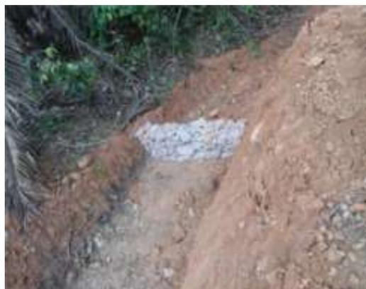
Foto 5 e 6 -Canaleta de drenagem com dique rochoso para retenção de sólidos e talude rocho para controle de instabilidade.
