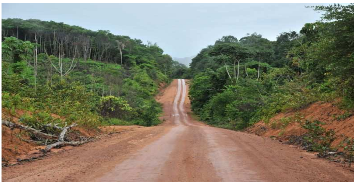
Foto 03: Rodovia BR-230 - Transamazônica - Acesso Itaituba / Jacareacanga
