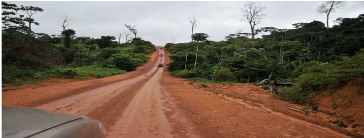
Foto 04: Rodovia BR-230 - Transamazônica - Acesso Itaituba / Jacareacanga
