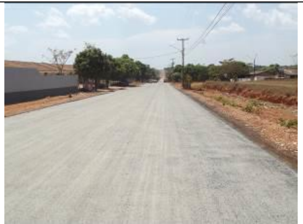
Figura 08: Pavimentação Avenida Teles Pires Alta Floresta.
