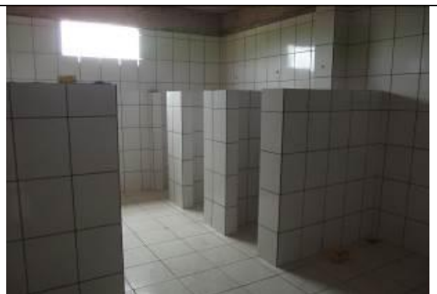
Figura 24: Vestiário do Ginásio Poliesportivo Jacareacanga - PA.
