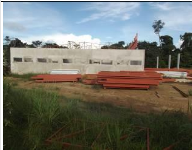
Figura 33: Construção da Rodoviária de Paranaíta.
