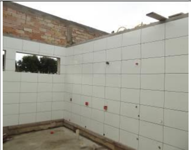
Figura 32: Construção da Rodoviária de Paranaíta.
