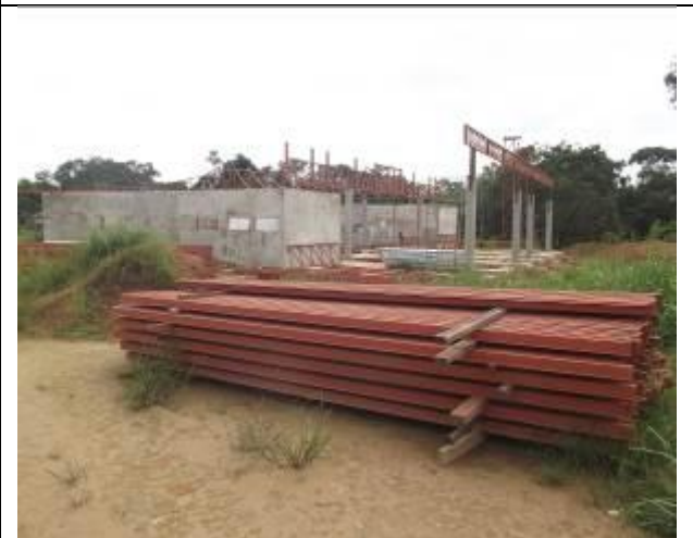
Figura 34: Montagem da estrutura do telhado da Rodoviária de Paranaíta.
