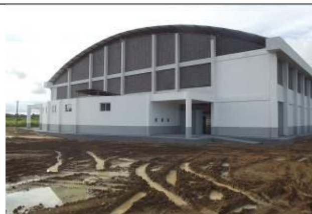
Figura 23: Construção do Ginásio Poliesportivo Jacareacanga - PA.
