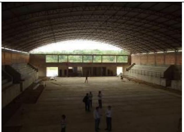
Figura 22: Construção do Ginásio Poliesportivo Jacareacanga - PA.
