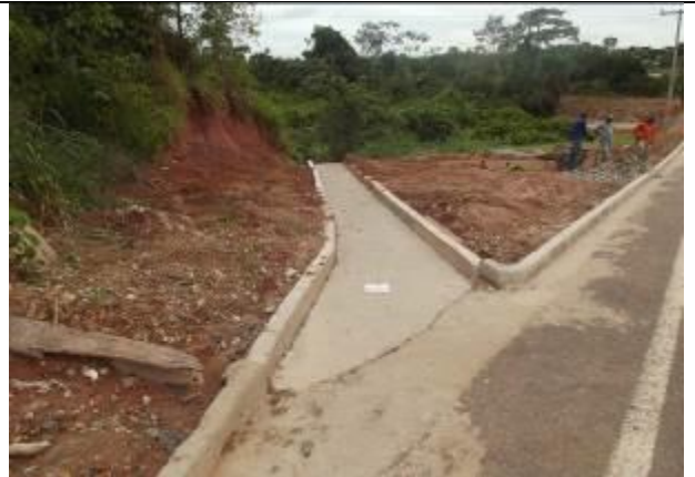
Figura 10: Pavimentação Avenida Teles Pires Alta Floresta.
