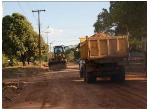
Figura 07: Pavimentação Avenida Teles Pires Alta Floresta.
