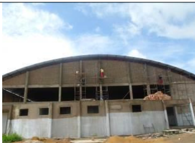
Figura 21: Construção do Ginásio Poliesportivo Jacareacanga - PA.
