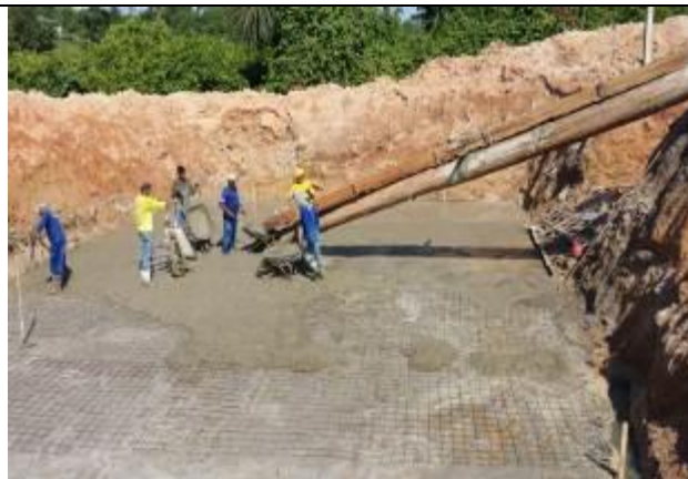
Figura 11: Construção do Bueiro Triplo Celular de Concreto Avenida Teles Pires Alta Floresta.
