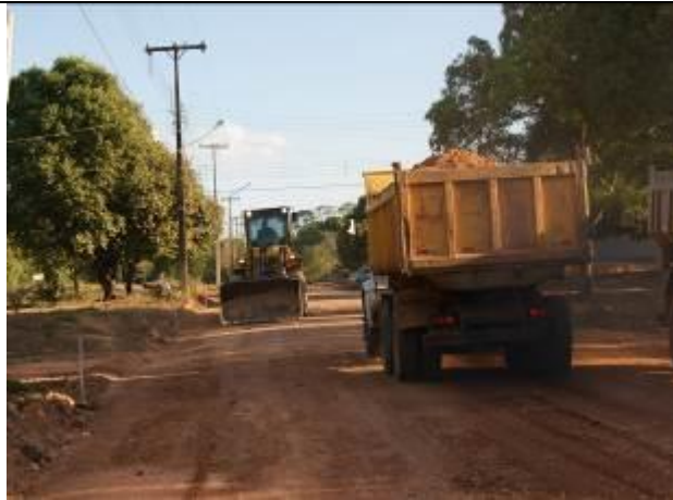
Figura 07: Pavimentação Avenida Teles Pires Alta Floresta.
