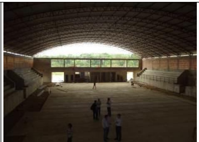
Figura 22: Construção do Ginásio Poliesportivo Jacareacanga - PA.
