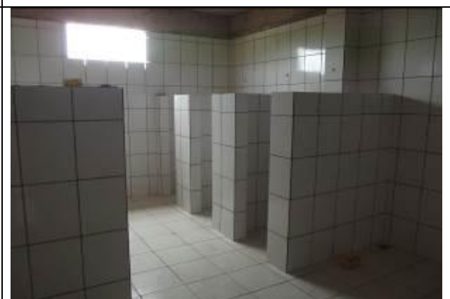
Figura 24: Vestiário do Ginásio Poliesportivo Jacareacanga - PA.
