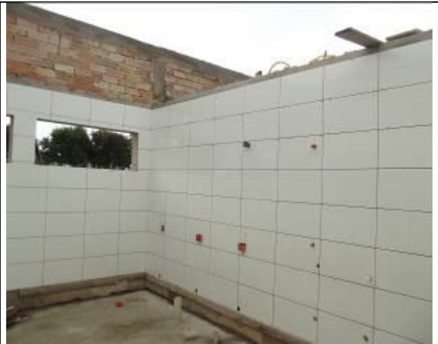
Figura 32: Construção da Rodoviária de Paranaíta.
