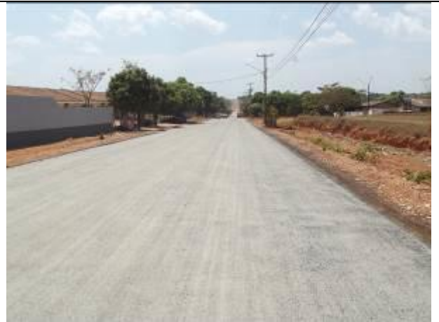
Figura 08: Pavimentação Avenida Teles Pires Alta Floresta.
