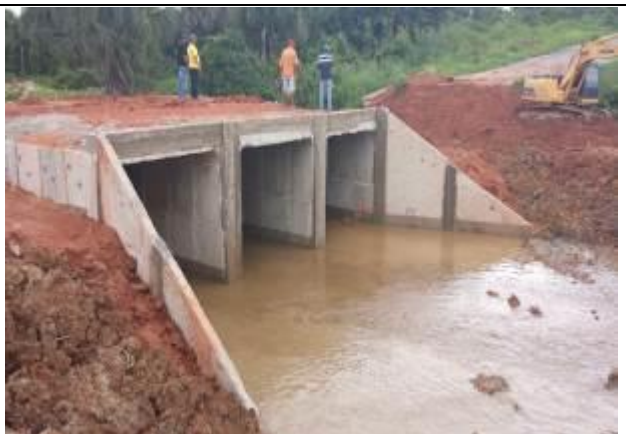
Figura 12: Conclusão do Bueiro Triplo Celular de Concreto Avenida Teles Pires Alta Floresta.
