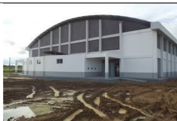
Figura 23: Construção do Ginásio Poliesportivo Jacareacanga - PA.
