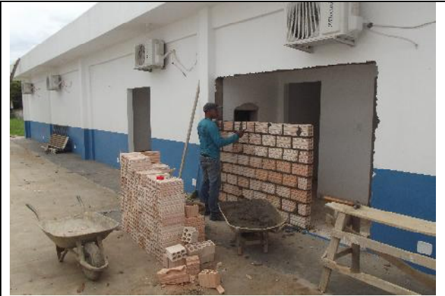
Figura 41: Adequações Centro Cirúrgico Hospital municipal Jacareacanga- PA.
