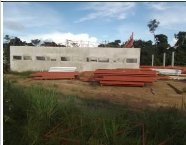
Figura 33: Construção da Rodoviária de Paranaíta.
