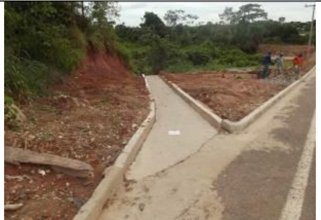
Figura 10: Pavimentação Avenida Teles Pires Alta Floresta.
