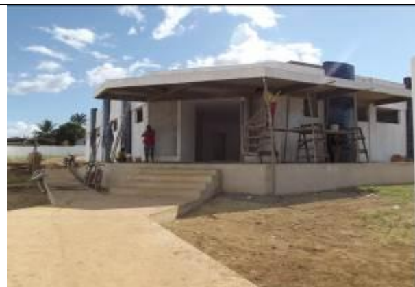
Figura 15: Construção do Centro de Referência em Assistência Social – CRAS Jacareacanga – PA.
