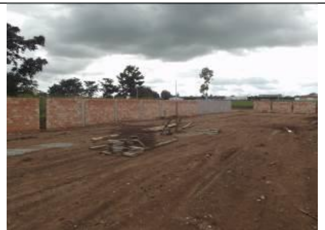
Figura 30: Construção do muro da Delegacia de Policia de Paranaíta – MT.
