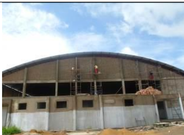
Figura 21: Construção do Ginásio Poliesportivo Jacareacanga - PA.
