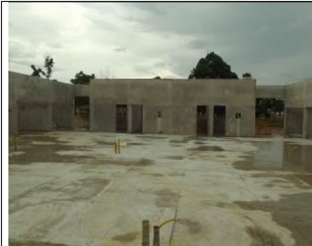
Figura 31: Construção da Rodoviária de Paranaíta.
