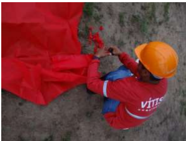
Figura 18. Preparo do TNT para o alinhamento.
