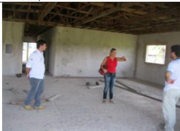
Foto 4 – Reunião de monitoramento do GT-2 – visita à obra do Centro de Convivência do Idoso – 09/10/13 – Alta Floresta/MT
