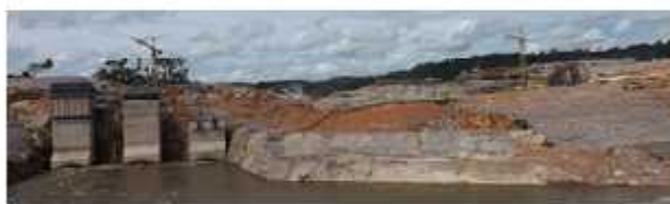
Consolidação do Derrão do Rio - Vltra de montante do canal de entrada e estrutura de controle
