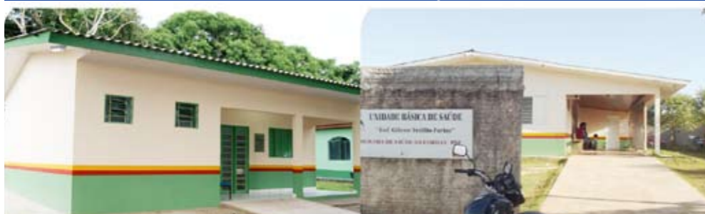
Construção do Posto de Atendimento Social na comunidade Santa Rita
