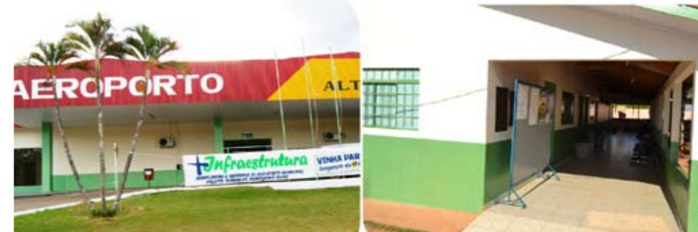
Reforma e ampliação do Aeroporto de Alta Floresta
