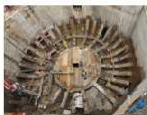
Círculo de Gestão - Casa de Foga - CF2 Montagem de fôrma, armação e concretagem dos berços de apoio da caixa egiptal
