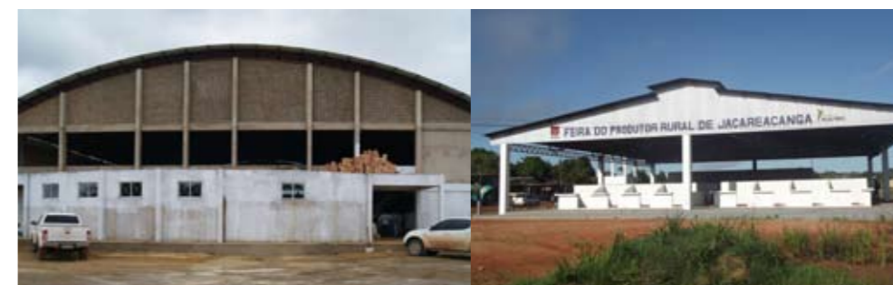
Construção do Ginásio de Esportes
