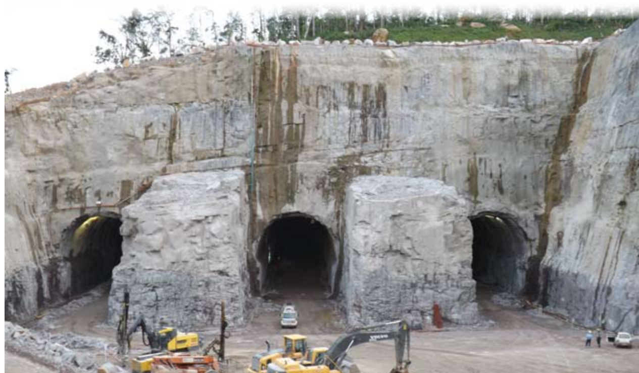
Fase da escavação subterrânea de três túneis (maio/2013)
