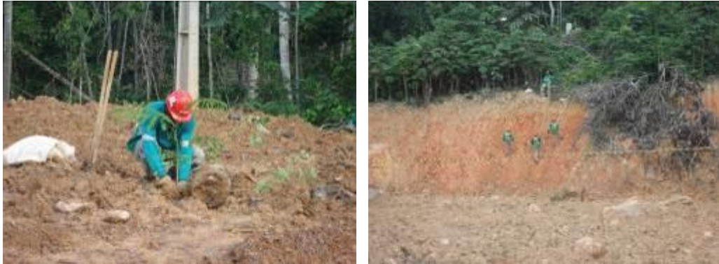
Plantio de Mudas e de Espécies Forrageiras em talude.
