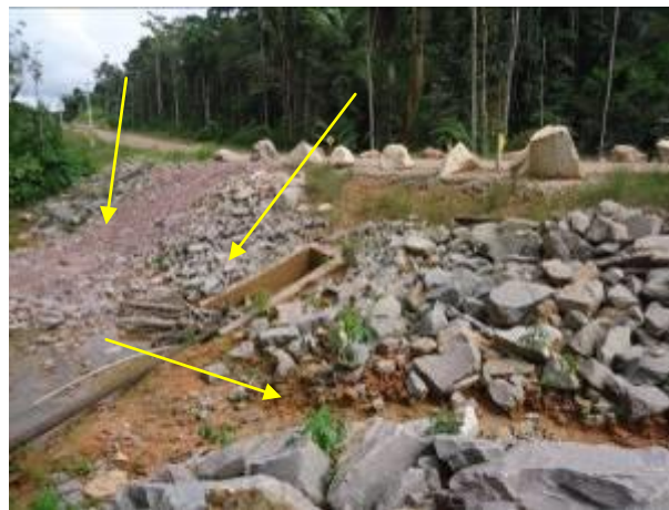
Bueiro com canaleta de drenagem, escada de rochosa e entubamento.
