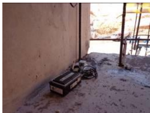
Monitoramento Tomada D'água
