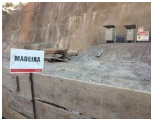
Boa prática – Reflexo dos treinamentos, instalação de baias para triagem e reuso de sucata metálica e madeira da construção civil na Casa de Força.
