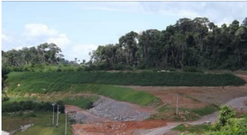
Bota-Fora da Subestação MD.
