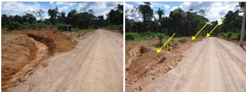
Canaleta de drenagem em nível.
