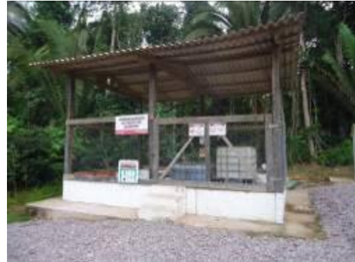
Galpão de armazenamento de produtos químicos.
