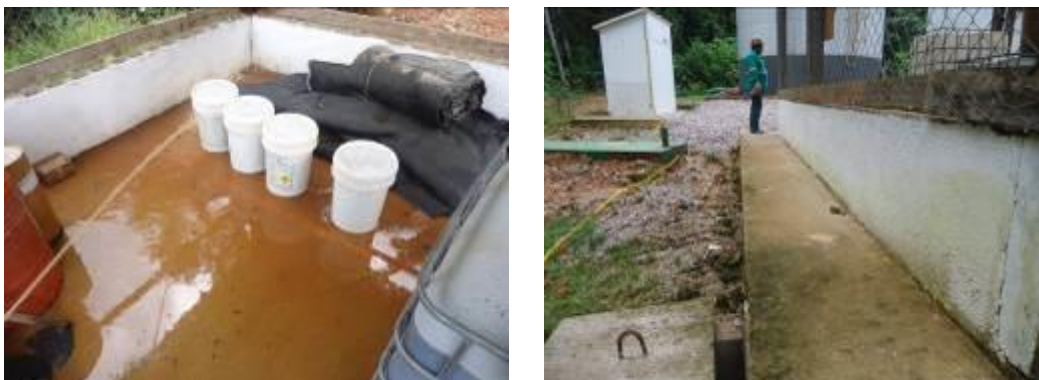
Teste de estanqueidade – Baía de Produtos Químicos - ETA 100 m 3
