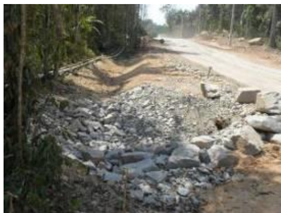
Canaleta de drenagem com dique rochoso e bacia de retenção.
