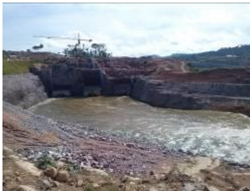
Emboque - Escavação subterrânea concluída.
