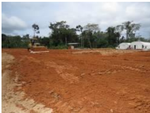
Realizando o reaferimento do relevo para a execução do PRAD.
