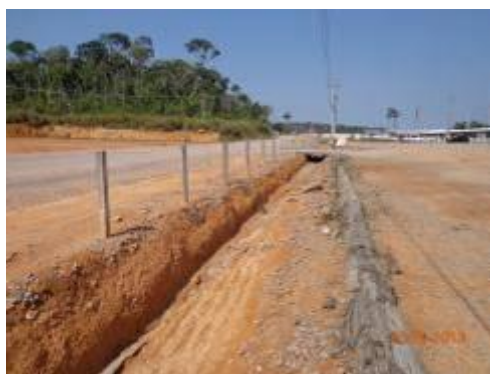
Instalação de seção drenante.
