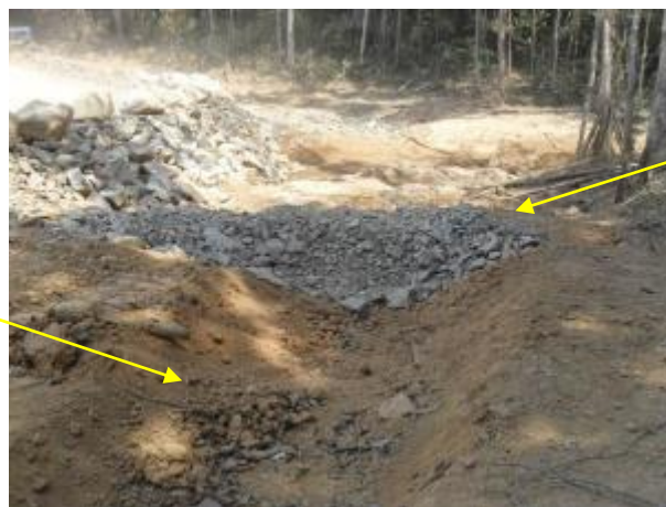
Talude de corte com canaleta de drenagem e dique rochoso para retenção de sólidos.
