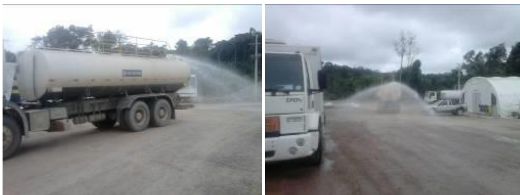
Umectação vias não pavimentadas – Acesso próximo ao Refeitório MD
