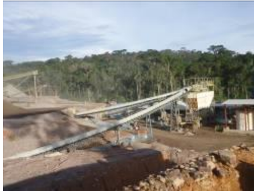
Envolvimento das esteiras da Central de Britagem ME e MD com tambores de reaproveitamento.
