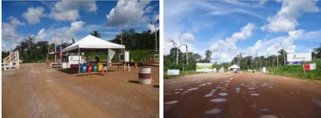
Portaria de acesso Canteiro de Obras da UHE Teles Pires
