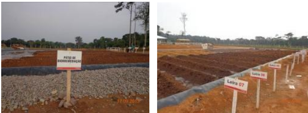
Pátio de Biorremediação - CGR.
