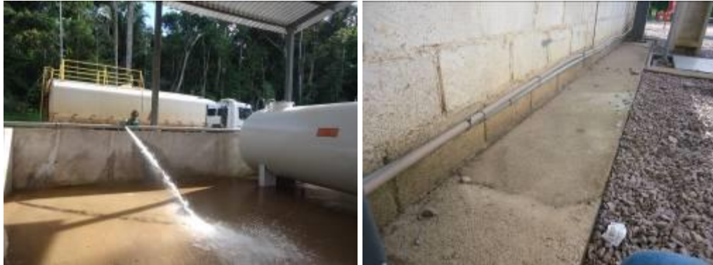
Teste de estanqueidade baía de contenção - Plante de Combustível.
