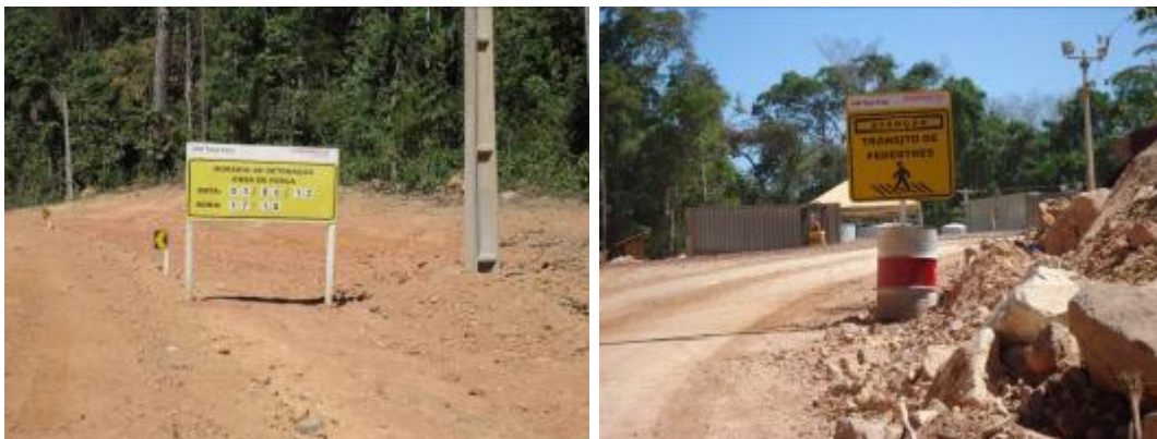
Sinalização barreira de isolamento detonação
