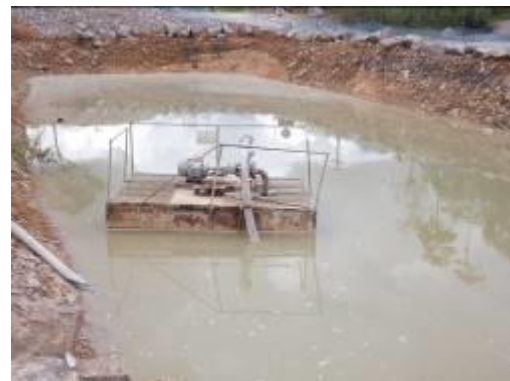
Processo de lavagem do balão da betoneira, aonde a água, ao chegar à segunda lagoa de decantação, é bombeado novamente para o início do processo, assim é feito o reuso da água.
