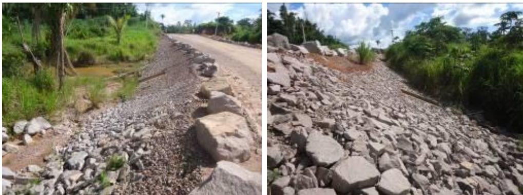
Bueiro com escada rochosa.
