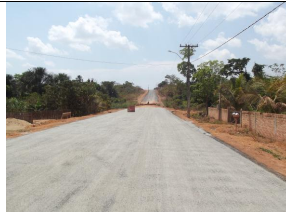
Figura 10: Retomada das obras Avenida Teles Pires
