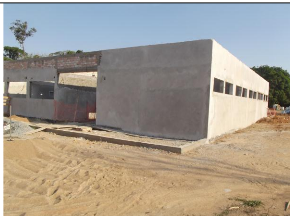
Figura 43: Obra Terminal Rodoviário de Paranaíta.
