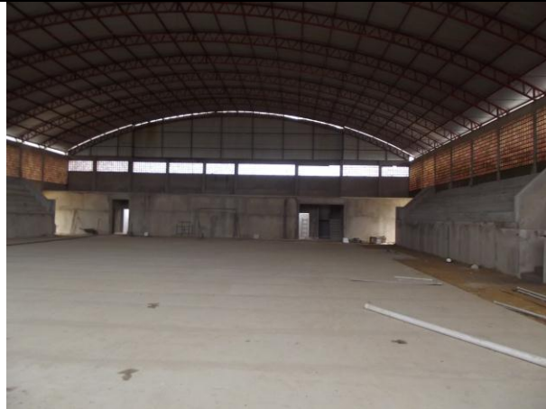
Figura 19: Obras do Ginásio Poliesportivo em fase final.
