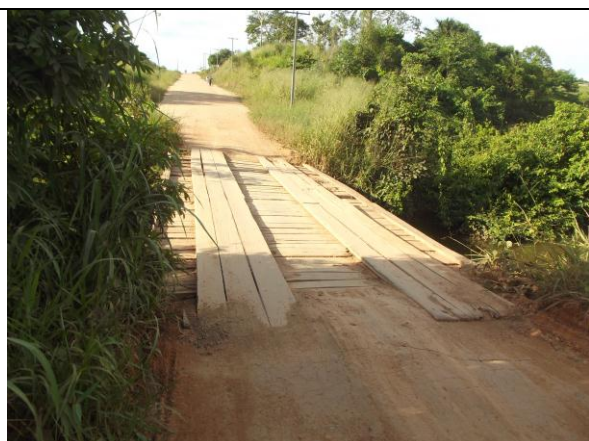
Figura 45: Obra Ponte de Madeira Avenida Teles Pires.
