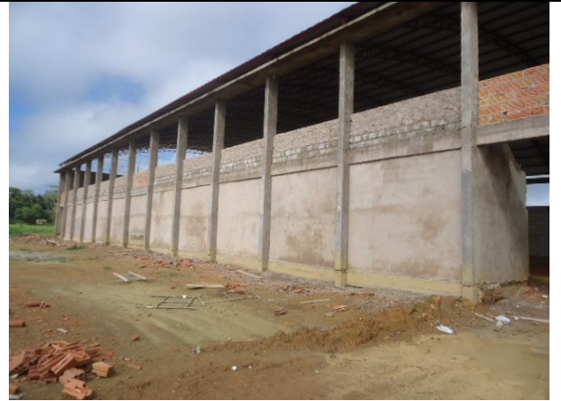
Figura 20: Obras do Ginásio Poliesportivo em fase final.
