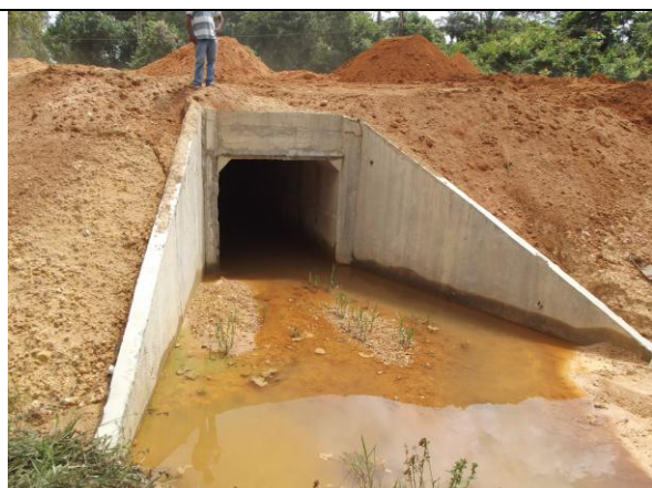
Figura 47: Obra Ponte de Madeira Avenida Teles Pires.
