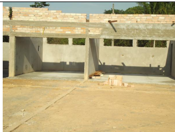
Figura 44: Obra Terminal Rodoviário de Paranaíta.
