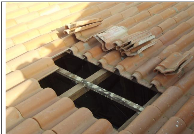
Figura 07: Vazamento na calha da caixa de água Unidade Previdenciária de Paranaíta.
