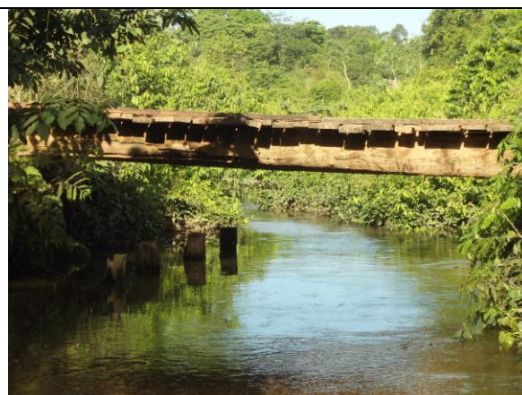
Figura 46: Obra Ponte de Madeira Avenida Teles Pires.
