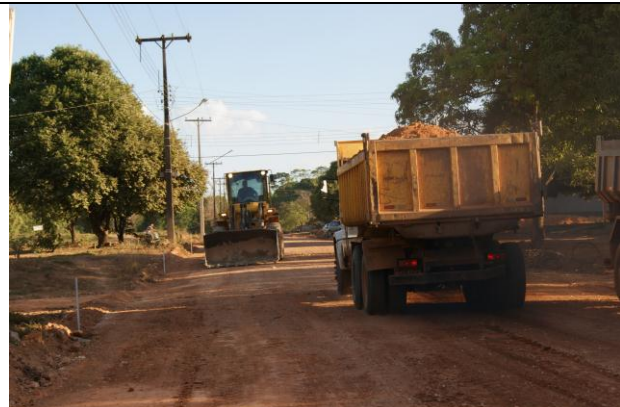
Figura 09: Retomada das obras Avenida Teles Pires
