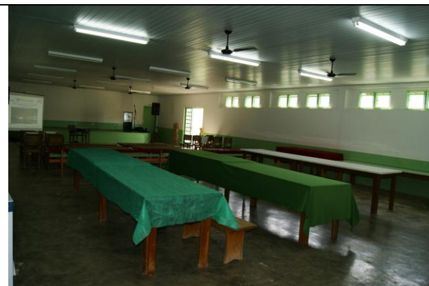
Figura 12: Reparo na Escola Jardim das Flores
