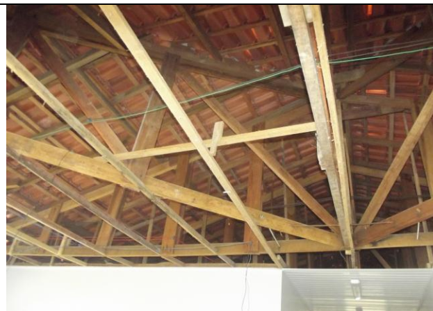
Figura 01: Reparo forro PSF II Paranaíta.
