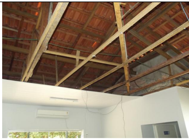
Figura 02: Reparo forro PSF II Paranaíta.
