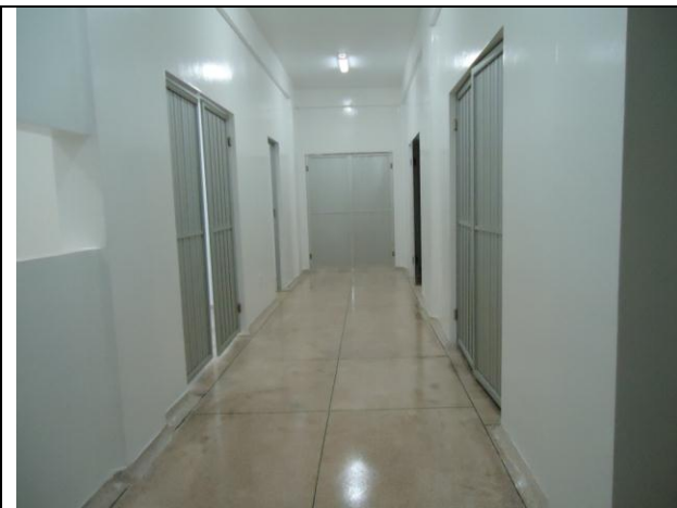
Figura 15: Centro Cirúrgico Jacareacanga em fase final.
