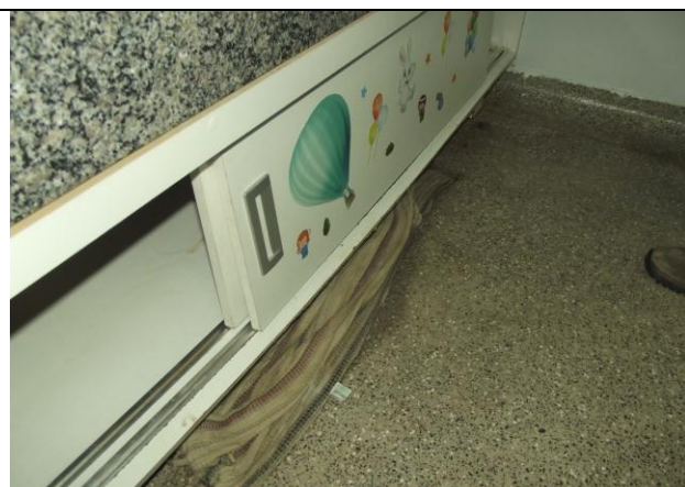
Figura 05: Reparo vazamento pia Escovódromo PSF IV Paranaíta.
