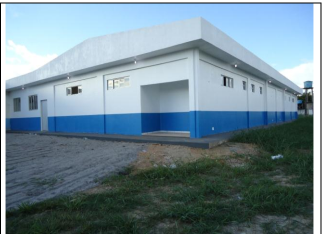
Figura 16: Centro Cirúrgico Jacareacanga em fase final.
