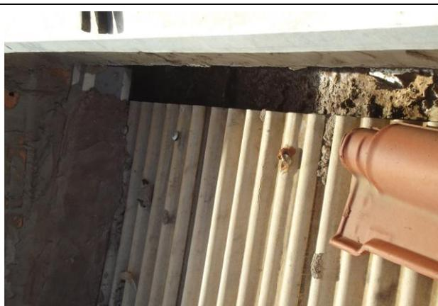
Figura 08: Vazamento na calha da caixa de água Unidade Previdenciária de Paranaíta.
