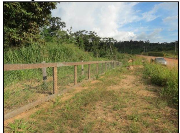
Figura 15. Acesso definitivo, Passagem N° 3. Detalhe da cerca guia.
