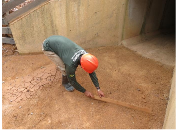
Figura 21. Nivelamento da cama de areia na passagem .
