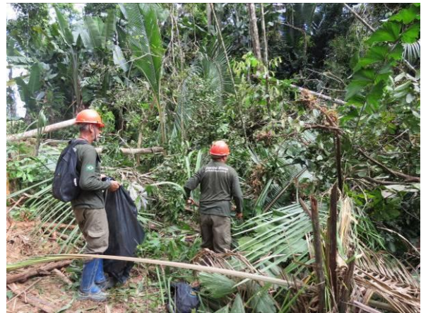
Figura 52. Acompanhamento das frentes de supressão vegetal na Linha de Transmissão.
