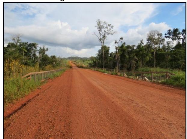
Figura 19. Acesso definitivo, Passagem N° 16. Detalhe da cerca guia.
