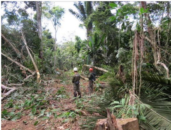
Figura 51. Acompanhamento das frentes de supressão vegetal na Linha de Transmissão.
