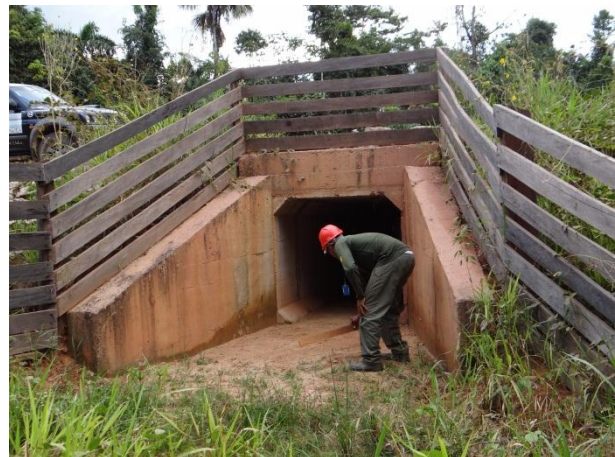
Figura 9. Acesso definitivo, Passagem N° 4. Detalhe da passagem e da “cerca-guia” de madeira.
