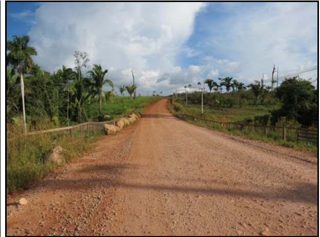
Figura 17. Acesso definitivo, Passagem N° 15. Detalhe da cerca guia nos dois lados da estrada.
