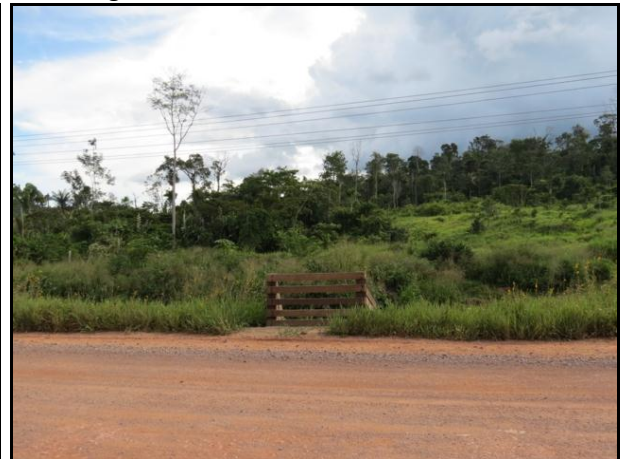
Figura 13. Acesso definitivo, Passagem N° 2. Detalhe da cerca guia.
