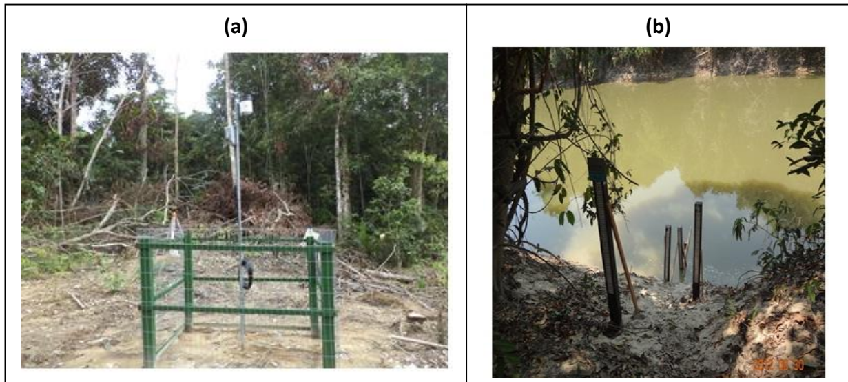
Figura 4. Montagem e instalação da estação telemétrica Paranaíta. (a) Visão geral da estação sendo montada com destaque ao pluviômetro; (b) Visão geral do local escolhido para a instalação da estação.
