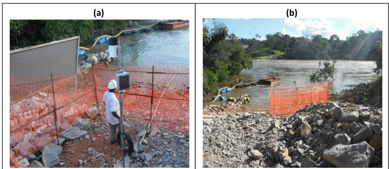
Figura 3. Montagem e instalação da estação telemétrica UHE. (a) Visão geral da estação sendo montada com destaque ao pluviômetro; (b) Visão geral do local escolhido para a instalação da estação.
