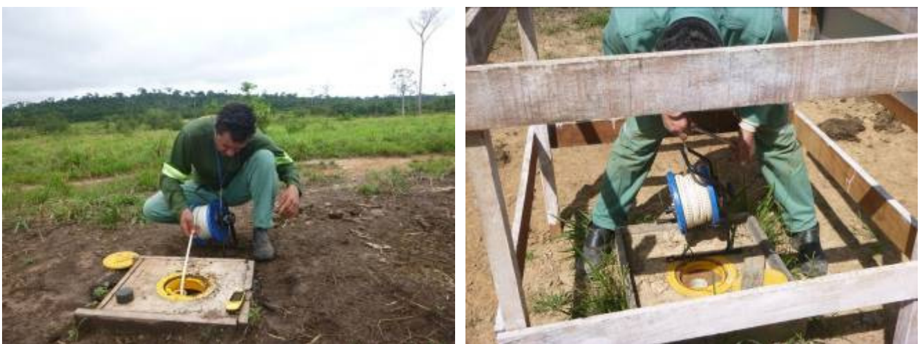
Figura 11 - Registro das leituras de nível realizadas no PZ07
