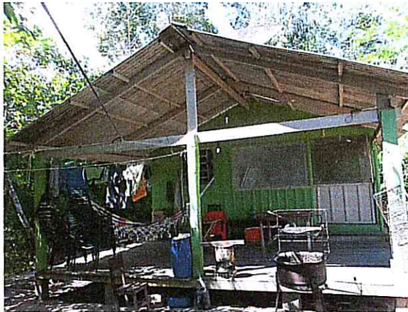
Benfeitoria Edificada na Ilha do Cachimbo
