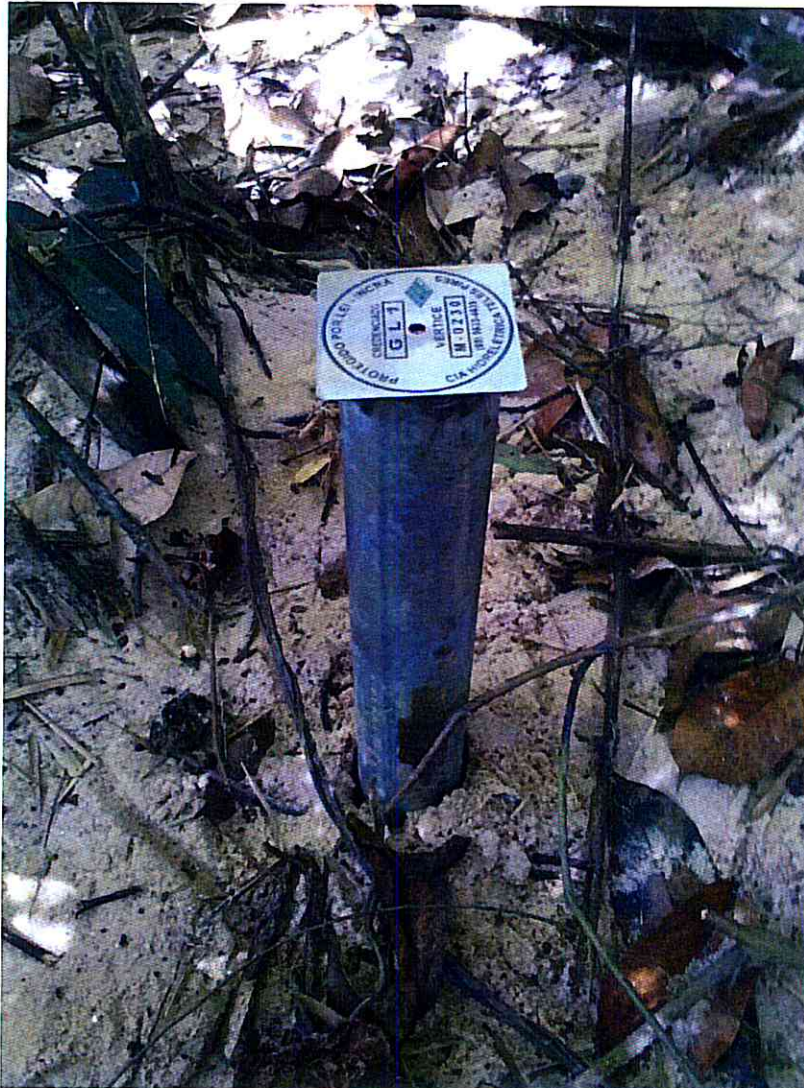
Fotografia 09 – Instalação de Marco de Ferro Galvanizado, contendo plaqueta de identificação de vértices, de acordo a Norma Técnica Para Georreferenciamento de Imóveis Rurais, 2ª Edição Revisada, do INCRA (Instituto Nacional de Colonização e Reforma Agrária).
