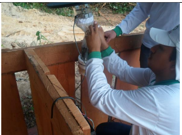
Foto 08 – Agente Instalando CDC
