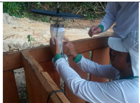
Foto 07 – Agente Instalando CDC
