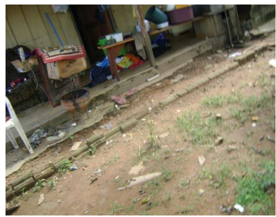
Inspeção de propriedade (LI).
