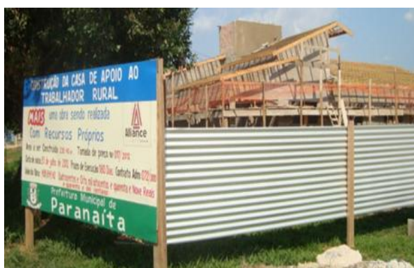
Obras: Casa de Apoio ao Trabalhador Rural
