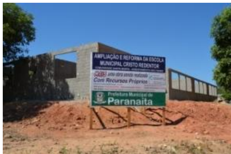
Obras de Ampliação – Escola Municipal Cristo Redentor
