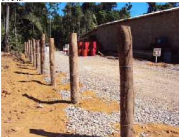
Foto 17. Construção de Cerca na CGR – ME, com o reaproveitamento de madeira.
