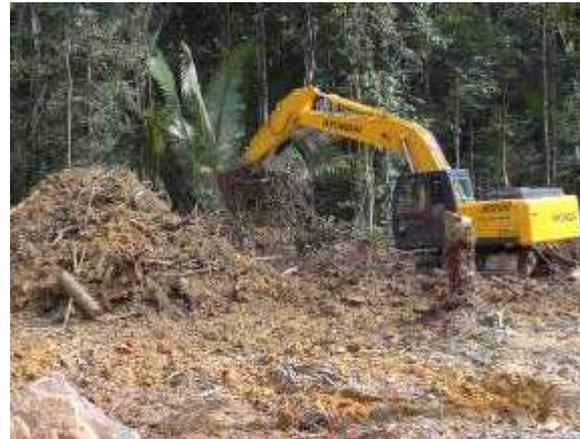
Foto 08. Remoção do solo vegetal com uso de escavadeira hidráulica.
