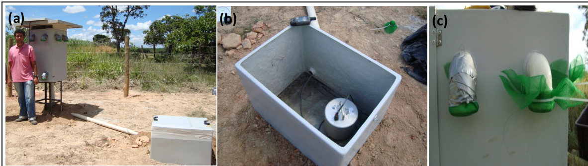
Figura 10. Exemplo de instalação dos abrigos das futuras estações sismográficas da UHE Teles Pires. (a) Abrigos da estação sismográfica RBMG da UHE Retiro Baixo em Minas Gerais. A esquerda da foto é mostrado o abrigo do registrador, onde é possível ver o painel solar sobre o telhado do abrigo, e à direita da foto se encontra o abrigo do sensor. O cano de PVC que liga os abrigos do registrador e do sensor está parcialmente descoberto na foto apenas para mostrar a conexão entre os dois abrigos. (b) Abrigo do sismômetro ainda aberto; (c) Detalhe das saídas de respiro da estação vedadas com tela de mosquiteiro.
