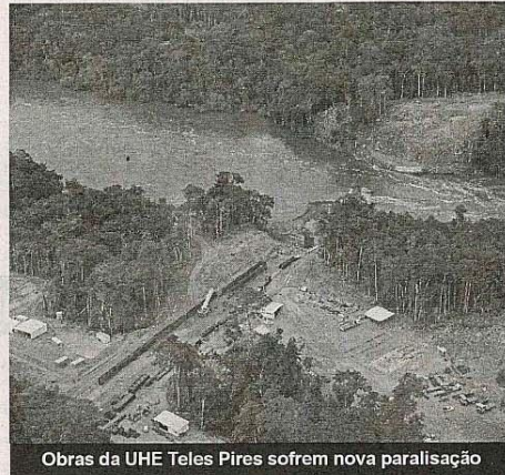
Obras da UHE Teles Pires sofrem nova paralisação
