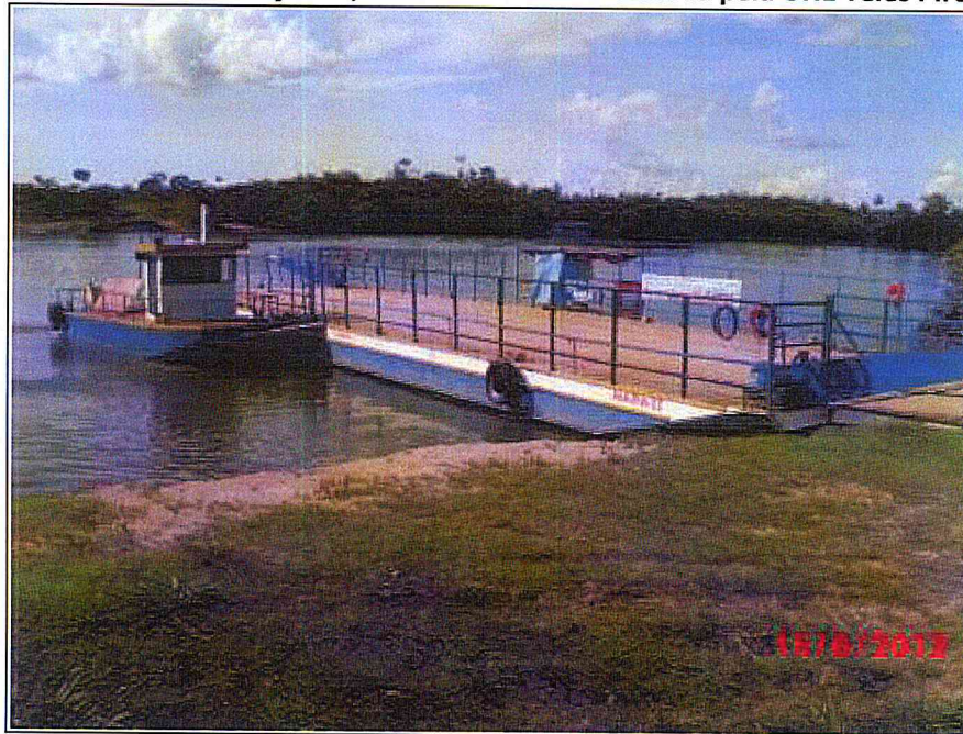
Figura 3 – Balsa do Cajueiro, localizada em área afetada pela UHE Teles Pires.
