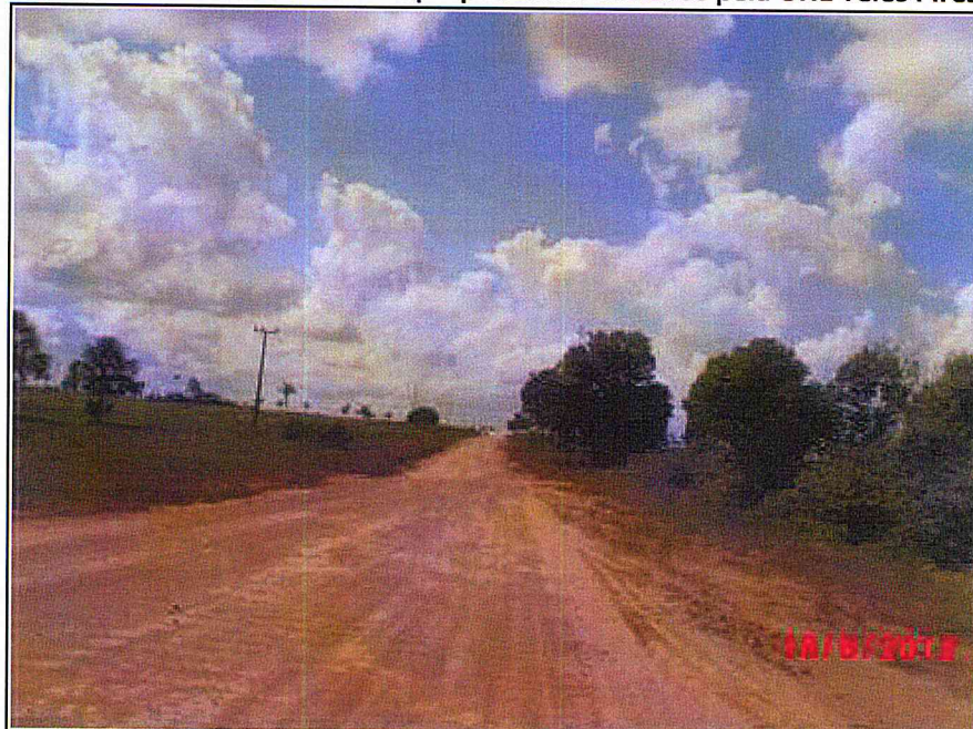
Figura 2 – Estrada de acesso às propriedades afetadas pela UHE Teles Pires.
