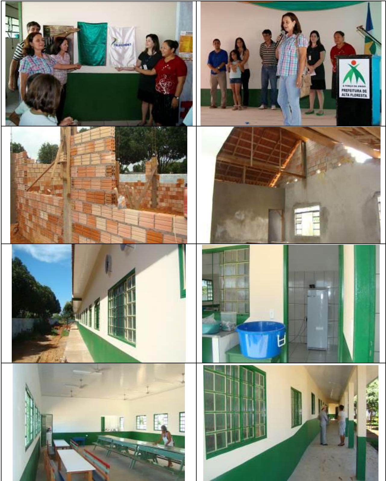
Reforma e Ampliação da Escola Municipal Jardim das Flores - Alta Floresta/MT
