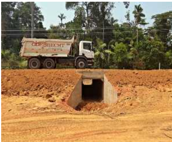
Foto 01 – Passagem de fauna nº 04 em construção no acesso definitivo.
