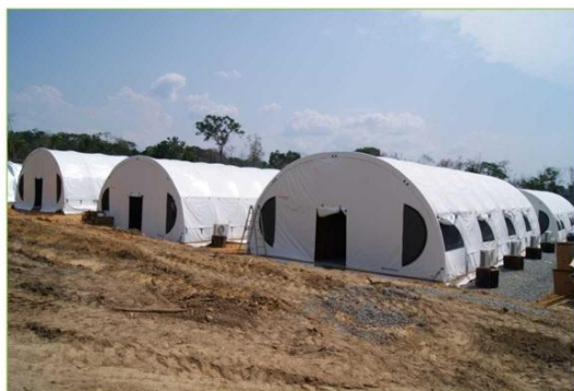
Tendas do canteiro pioneiro
