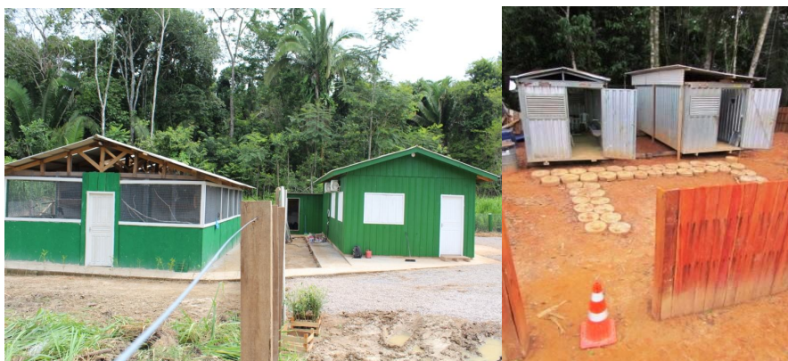
Figura 3 – Vista frontal do CPTFS (Margem esquerda) e vista frontal do CPTFS de apoio (Margem direita).
