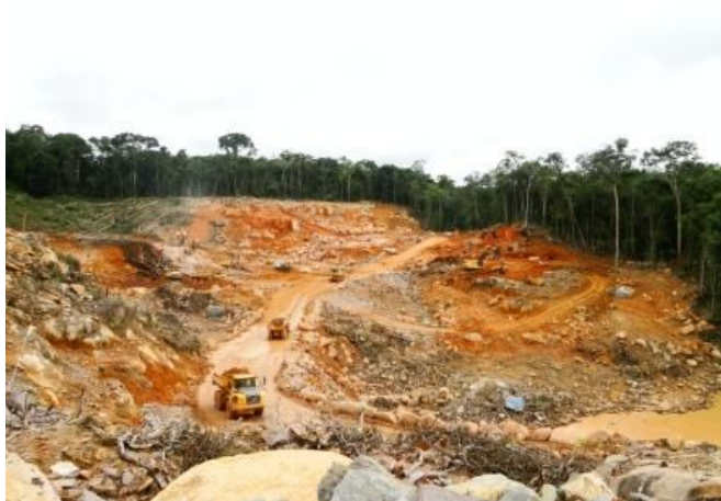
Figura 2 – Visão do canteiro de obras com vegetação típica ao fundo
