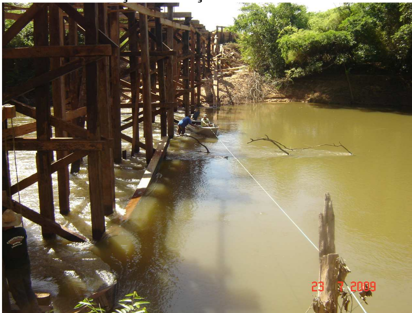
Figura 2.16 Ponte em Construção na Seção TPI-8 sobre o Rio Paranaíta
