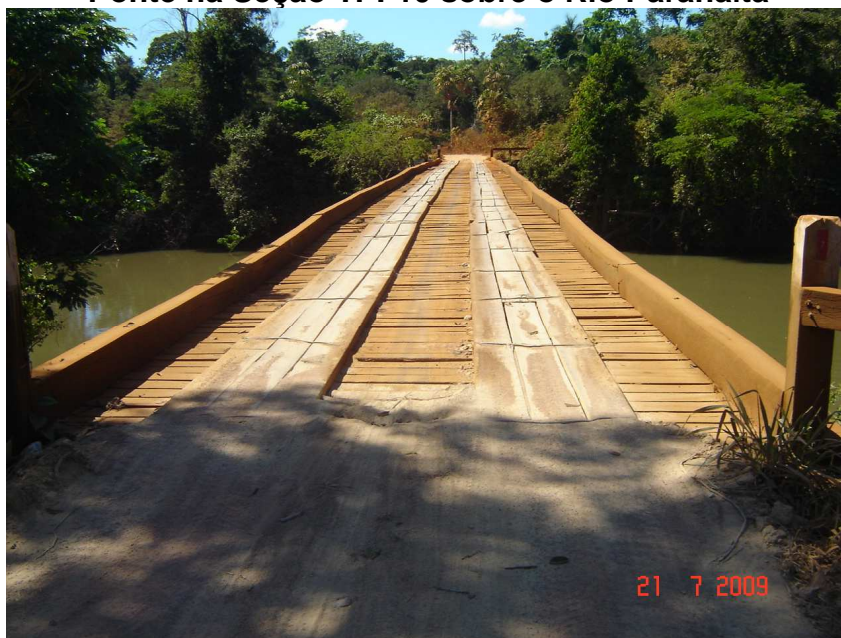
Figura 2.17 Ponte na Seção TPI-10 sobre o Rio Paranaíta
