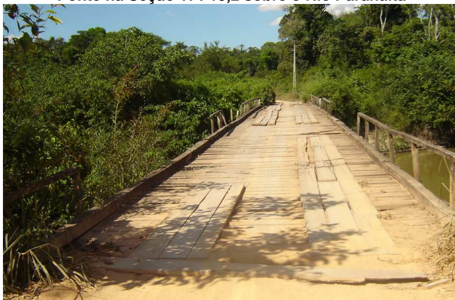
Figura 2.18 Ponte na Seção TPI-13,2 sobre o Rio Paranaíta
