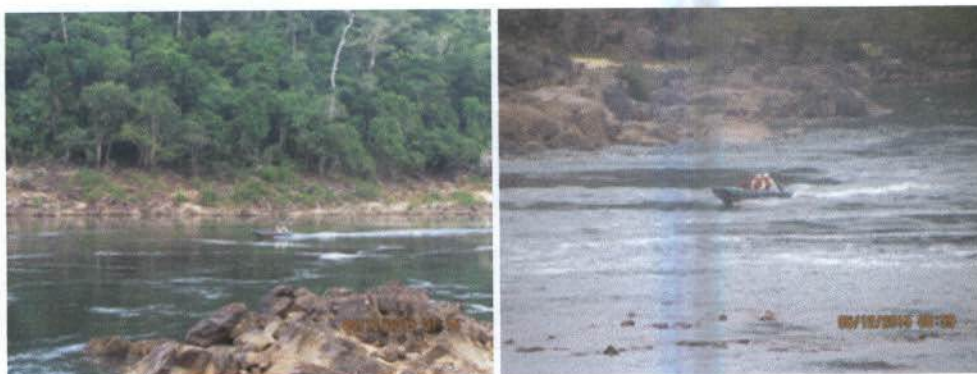
Prancha 05. Vistoria no canal de fuga.
