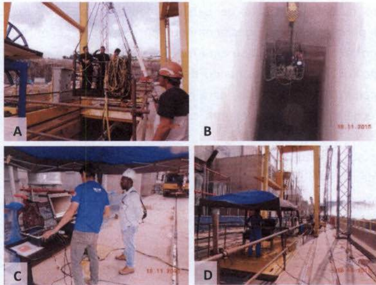
Prancha 21. A e B - Início da atividade de mergulho nas UG's; C e D – Acompanhamento através do monitor.
