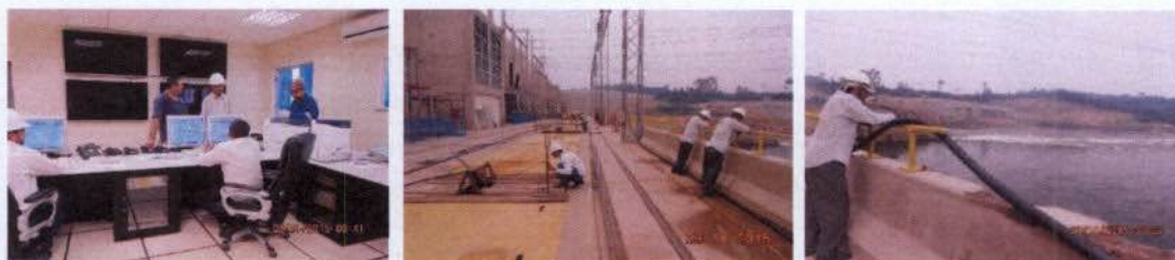
Prancha 01. Comando de partida da UG2, operação das grades anti-cardume e monitoramento canal de fuga durante as partidas da UG2
