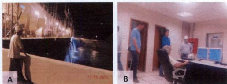
Prancha 24. A – Observação do canal de fuga durante a partida; B – Técnicos da Power Bus responsáveis pelo monitoramento do TC (Transformador de correntes)
