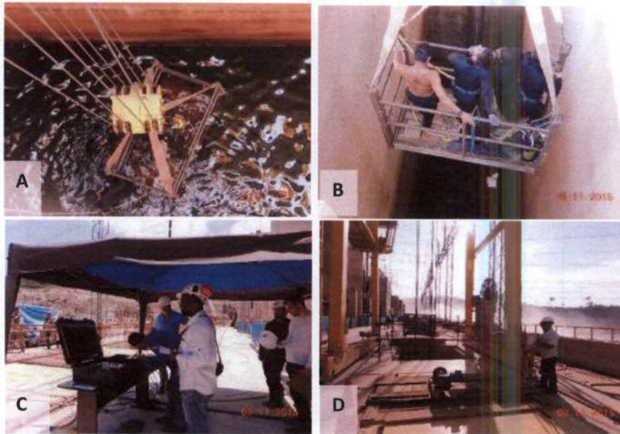
Prancha 03. A e B – Equipe de mergulhadores iniciando as atividades; C – Acompanhamento através do monitor de vídeo; D – Ajuste e posicionamento das grades anti cardumes.
