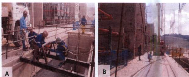
Prancha 14. A – Substituição da talha UG03; B – Substituição da grade ante cardumes da UG05.
