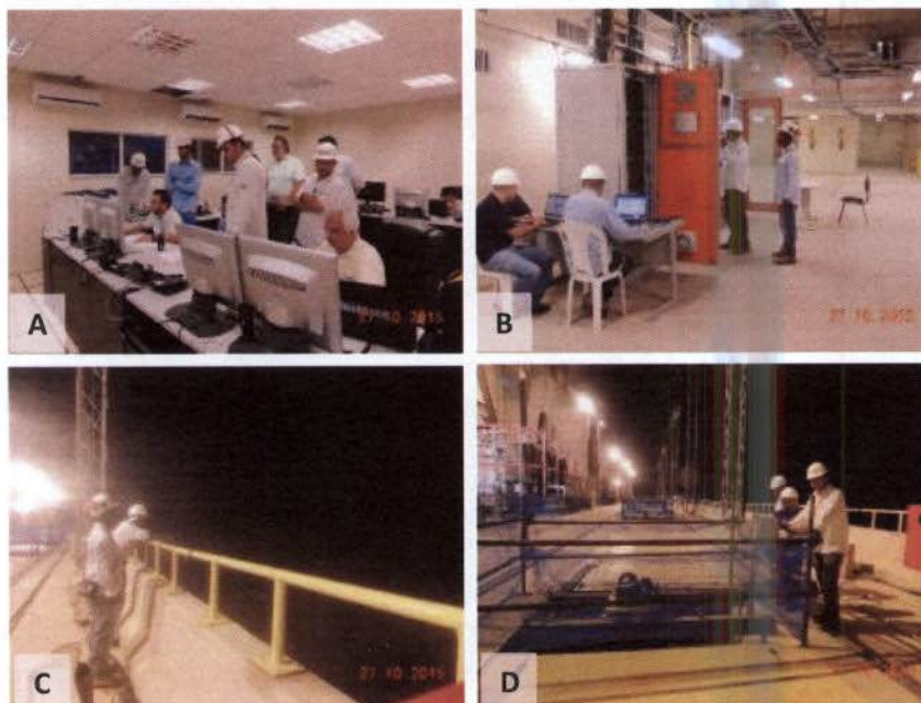
Prancha 13. Acompanhamento dos testes na sala de controle; B – Painel do RV na galeria elétrica; C – Observação do canal de fuga durante a partida; D – Procedimentos de manobras das grades anticardumes.
