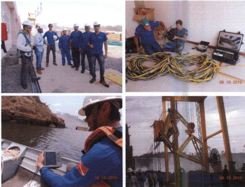
Prancha 24. A. Biólogos e equipe de mergulhadores; B. Preparo o equipamento de mergulho; C. Utilização de sonar para escaneamento do canal de fuga; D. Retirada da viga pescadora do vão 1 da unidade geradora 1.
