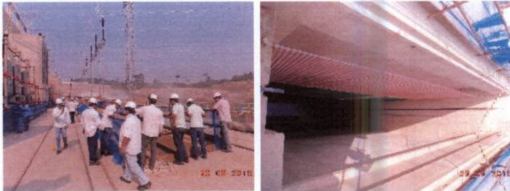
Prancha 09. A – Instalação da tela de contenção UG02; B – Tela instalada na UG02.
