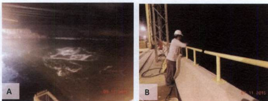
Prancha 49. A – Canal de fuga durante as partidas. B – Observação do canal de fuga.
