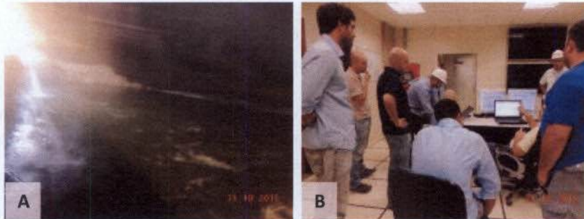
Prancha 26. Canal de fuga durante os testes de rejeição de carga; B – Equipe analisando resultados.
