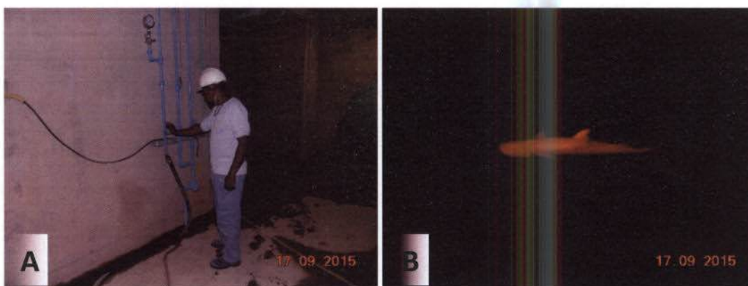
Prancha 08. A – Manobra de injeção de ar na sucção para afugentamento dos peixes e B - peixes visualizados no canal de fuga durante partida UG02.
