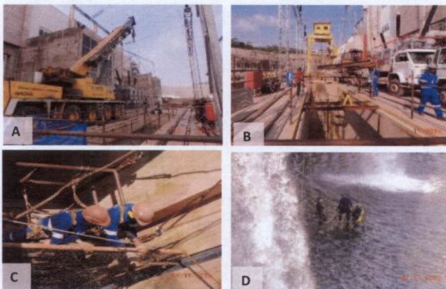
Prancha 47. A – Troca da grade anticardumes; B – Substituição da talha da UG02 pela talha da UG 03; C – Instalação de roldanas e D – Mergulho para verificação de sobras vestígios da grade que foi danificada.
