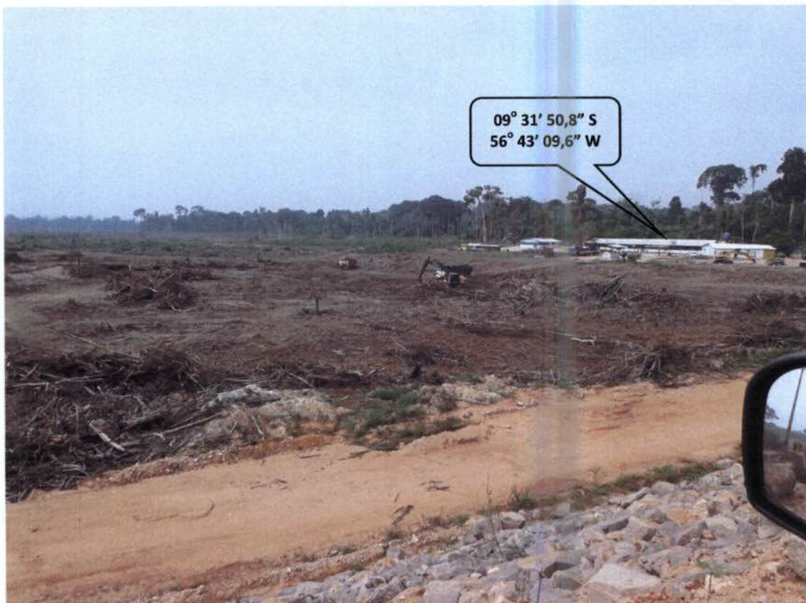
Foto 19. Área 02, Foto em 01/10/2014, no Lote D, próximo à ponte sobre o rio Paranaíta na MT 206, na margem esquerda do rio Paranaíta.
