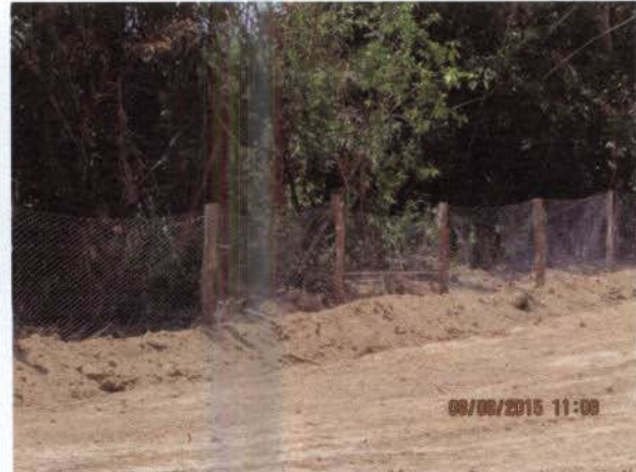
Foto 20. Madeira proveniente da supressão sendo utilizada no local como mourões para construção de cerca de isolamento.
