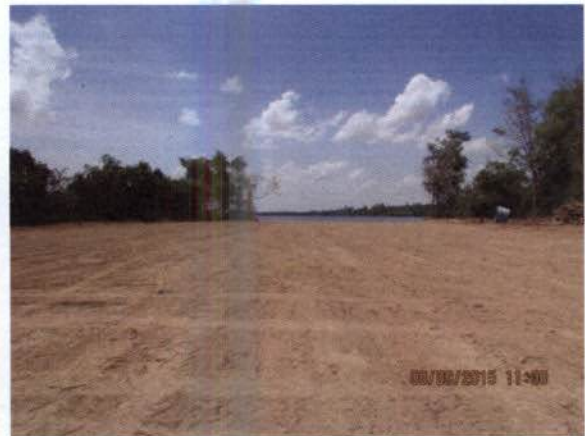
Foto 30. Vista parcial da área após a conclusão dos serviços de supressão vegetal e limpeza das áreas.
