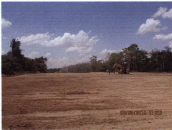
Foto 29. Vista parcial da área após a conclusão dos serviços de supressão vegetal e limpeza das áreas.
