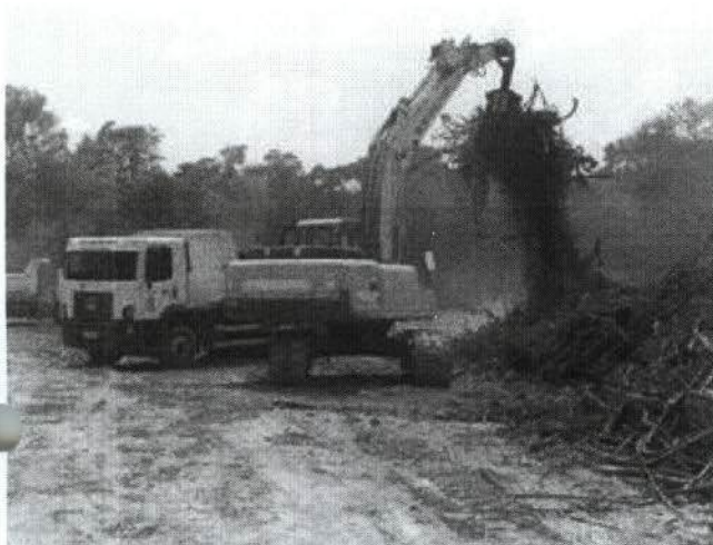
Foto 01. Retirada dos resíduos com uso de caminhão basculante e escavadeira hidráulica com pinça.
