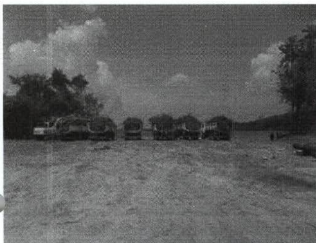
Foto 03. Retirada dos resíduos com uso de caminhão basculante e escavadeira hidráulica com pinça.
