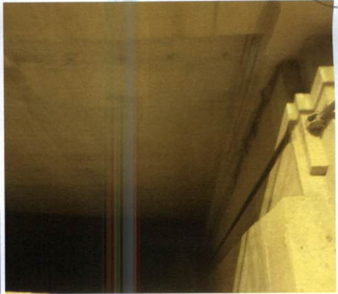
Figura 6 – Fenda por onde a tela anti cardume deve descer.
