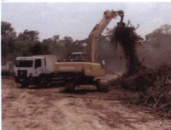
Foto 23. Retirada dos resíduos com uso de caminhão basculante e escadeira hidráulica com pinça.
