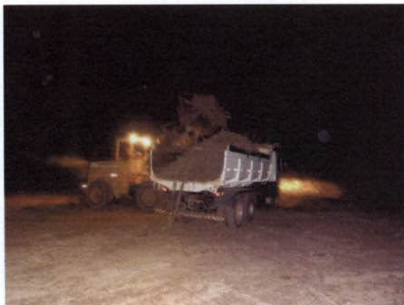
Foto 25. Retirada dos resíduos com uso de caminhão basculante e pá carregadeira.
