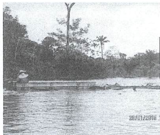
Foto 04. Equipas rebocando/empurrando material flutuante.
