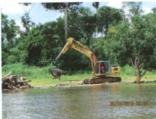
Foto 09. Retirada do material acumulado com uso de escavadeira hidráulica com pinça.
