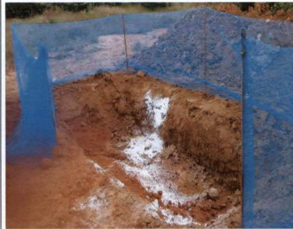
Foto 10 – Detalhe do interior da vala, observando-se o cal utilizado.
