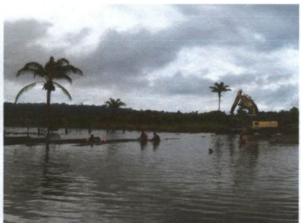
Foto 22. Equipe soltando as toras das pilhas atingidas.
