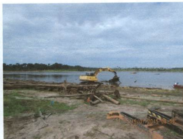
Foto 10. Retirada do material acumulado com uso de escavadeira hidráulica com pinça.
