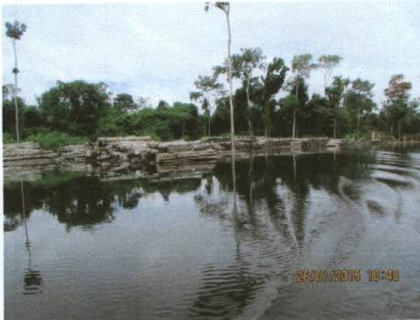
Foto 13. Pátio de estocagem foi parcialmente inundado nas primeiras pilhas de madeira com desmoronamento de lenha e toras.
