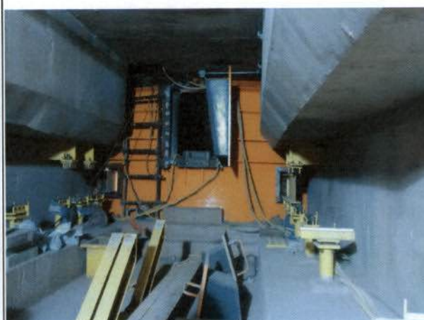
Foto 20 – Portinhola de acesso a 1ª turbina no interior da casa da força.
