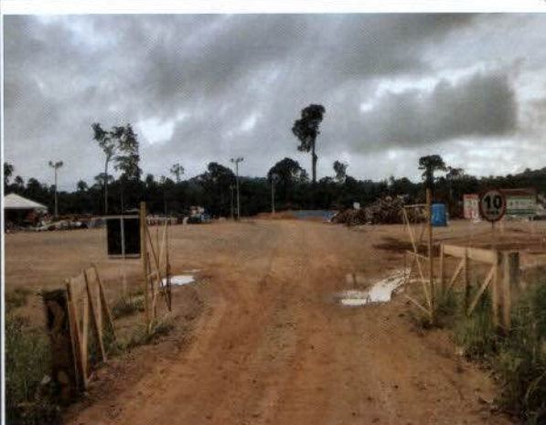
Foto 08. – Entrada do Centro de Gerenciamento de Resíduos Sólidos (CGR). Observar vala de enterrio de peixes ao fundo da imagem.
