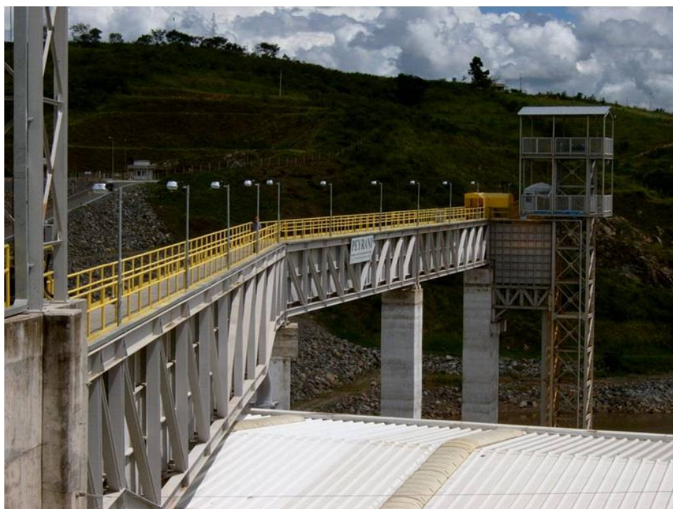
Foto 3 – Canal de Saída
