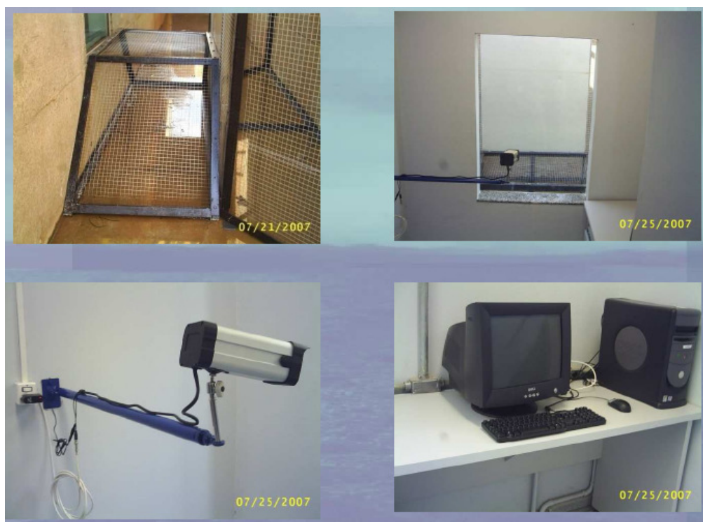
Foto 7 – Sala de Observação
