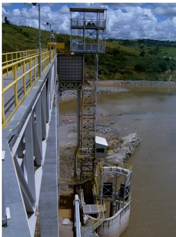
Foto 2 – Canal de Entrada, Captura e Torre de Elevação
