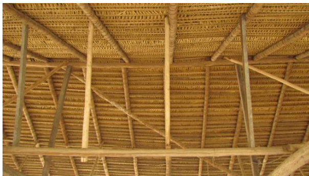
Foto 41: Detalhe da cobertura da sala de reuniões da aldeia Marmelos 2 (17/11/14), feita com troncos de wyratinga ( Rubiaceae sp) e palha de babaçu ( Attalea speciosa ), presas com cipó-titica ( Heteropsis flexuosa ).
