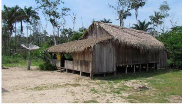
Foto 07: Detalhe de residência na aldeia Jakuí (05/11/14), construída com tábuas serradas e com cobertura de palha de babaçu ( Attalea speciosa ).
