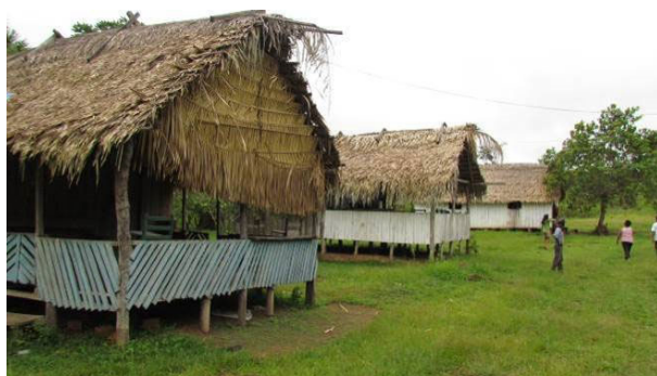
Foto 35: Detalhe de construções na aldeia Karanaí (16/11/14), construídas com tábuas serradas e com cobertura de palha de babaçu ( Attalea speciosa ).
