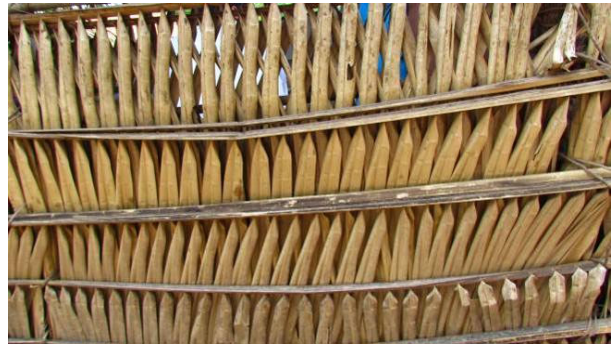
Foto 04: Detalhe da cobertura lateral da sala de reuniões da aldeia Mafuí (08/11/14), feita com palha de babaçu ( Attalea speciosa ).
