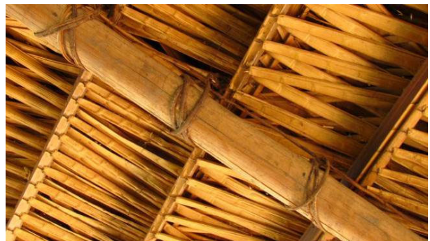
Foto 06: Detalhe da amarração feita na cobertura da sala de reuniões da aldeia Mafuí (08/11/14), com cipó-titica ( Heteropsis flexuosa ), que prende as palhas de babaçu ( Attalea speciosa ) em troncos de muiratinga ( Moraceae sp).
