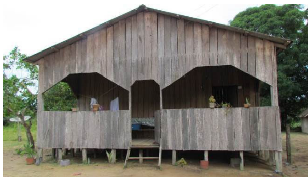
Foto 45: Detalhe de residência na aldeia Marmelos 1 (18/11/14), toda construída com tábuas serradas e com cobertura de telhas de fibrocimento onduladas. Observar os esteios na base da casa, que evitam o contato direto com o solo.
