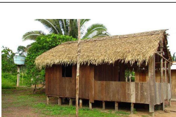
Foto 15: Detalhe de residências na aldeia Taboka (09/11/14), construídas com tábuas serradas e com cobertura de palha de babaçu ( Attalea speciosa ) e telhas de fibrocimento onduladas.
