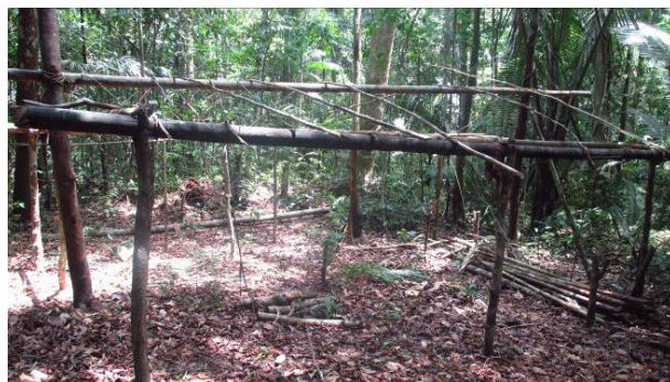
Foto 60: Estrutura de tapiri sem cobertura localizado nos arredores da aldeia Mafuí. O tapiri é considerado o local de “descanso da família, para caçar e passar um tempo na matas”. (Cacique José Milton Tenharim, aldeia Trakuá, 13/11/2014).
