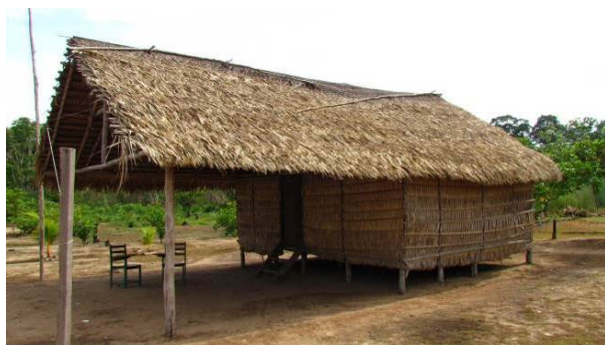
Foto 29: Detalhe de casa na aldeia Trakuá (13/11/14), toda construída com palhas de babaçu ( Attalea speciosa ) e estrutura de madeira de diferentes espécies arbóreas.
