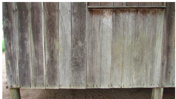
Foto 54: Detalhe de parede de casa feita com tábua de angelim ( Hymenolobium sp.).
