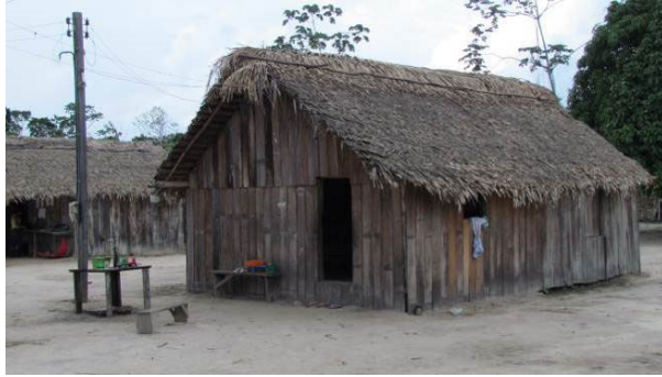
Foto 49: Detalhe de residência na aldeia Vila Nova (19/11/14), construída com tábuas e cobertura de palhas de babaçu ( Attalea speciosa ).
