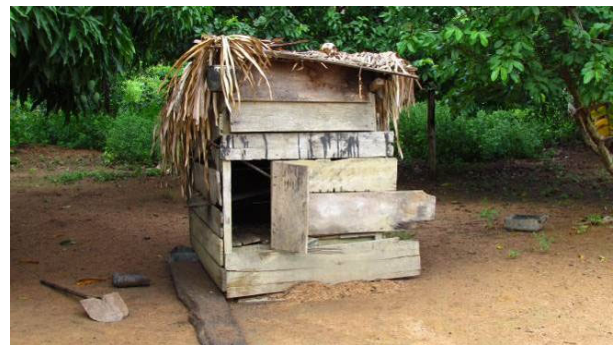
Foto 12: Detalhe de galinheiro na aldeia Kastanheira (06/11/14), construído com tábuas serradas.
