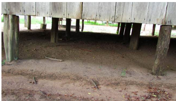
Foto 53: Detalhe de estrutura de casa na aldeia Mafuí (07/11/14), com esteios de acariquara ( Minquartia guianensis ) e itaúba ( Mezilaurus sp.), “bastante resistentes em contato com a terra”.
