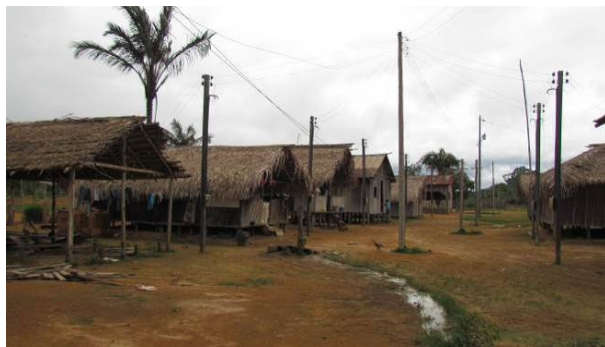
Foto 33: Detalhe de residências na aldeia Bela Vista (15/11/14), construídas com tábuas serradas e com cobertura de palha de babaçu ( Attalea speciosa ) e telhas de fibrocimento onduladas.
