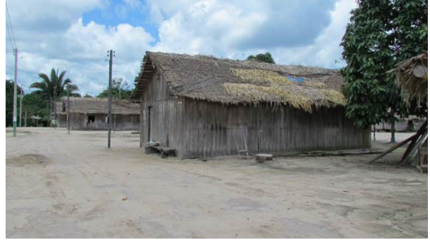
Foto 50: Detalhe de residências na aldeia Vila Nova (19/11/14), construídas com tábuas e cobertura de palhas de babaçu ( Attalea speciosa ).
