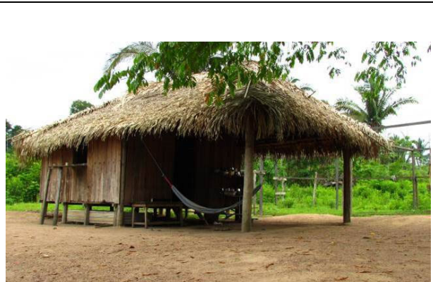
Foto 14: Detalhe da cobertura da sala de reuniões da aldeia Kastanheira (06/11/14), feita com ripas de maçaranduba ( Manilkara bidentata ) e ipê ( Tabebuia sp) e palha de babaçu ( Attalea speciosa ), presas com cipó-titica ( Heteropsis flexuosa ).
