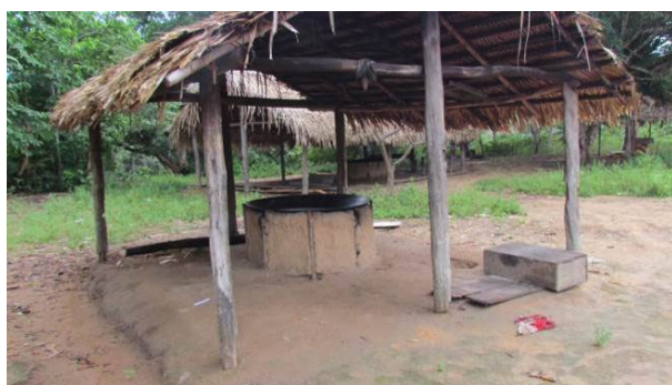
Foto 47: Detalhe de barracão da casa de farinha na aldeia Marmelos 1 (18/11/14), construído com madeira e cobertura de palha de babaçu ( Attalea speciosa ).
