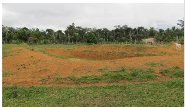
Foto 60: Detalhe de construção de tanques para criação de peixes na aldeia Bela Vista (15/11/14).
