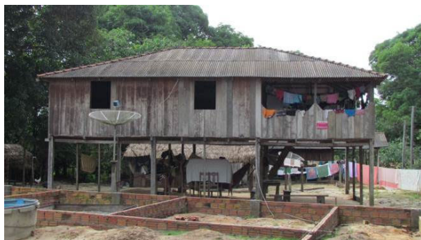
Foto 43: Detalhe de residência na aldeia Marmelos 2 (17/11/14), construída com tábuas serradas e com cobertura de telhas de fibrocimento onduladas. Observar o alicerce de uma nova casa sendo construído com tijolos e cimento.
