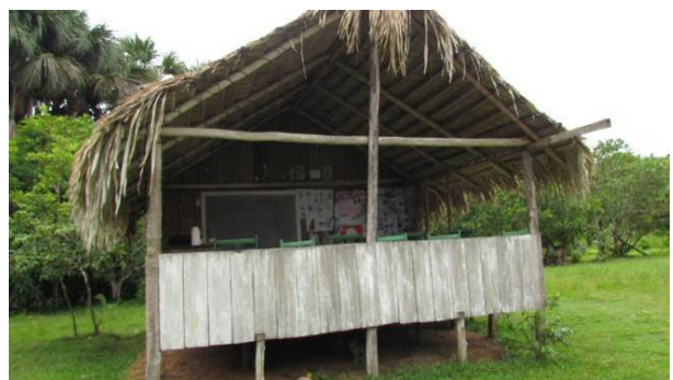
Foto 36: Detalhe da escola da aldeia Karanaí (16/11/14), construídas com tábuas serradas e com cobertura de palha de babaçu ( Attalea speciosa ).
