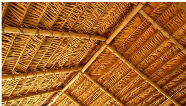
Foto 05: Detalhe da cobertura da sala de reuniões da aldeia Mafuí (08/11/14), feita com estipe e palha de babaçu ( Attalea speciosa ), presas com cipó-titica ( Heteropsis flexuosa ).
