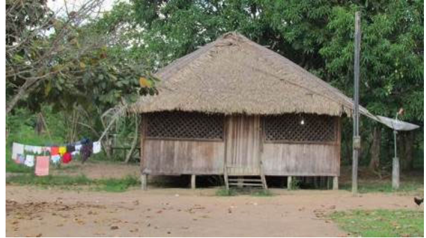
Foto 02: Detalhe de residências na aldeia Mafuí (07/11/14), construída com tábuas serradas e com cobertura de palha de babaçu ( Attalea speciosa ).
