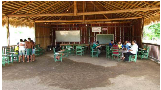
Foto 32: Detalhe da escola da aldeia Trakuá (13/11/14), construída de tábuas e cobertura com palhas de babaçu ( Attalea speciosa ).
