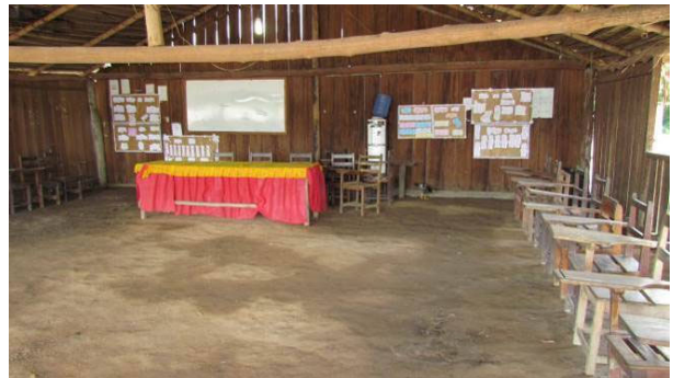
Foto 52: Detalhe de escola da aldeia Vila Nova (19/11/14), construída com tábuas serradas e cobertura de palhas de babaçu ( Attalea speciosa ).
