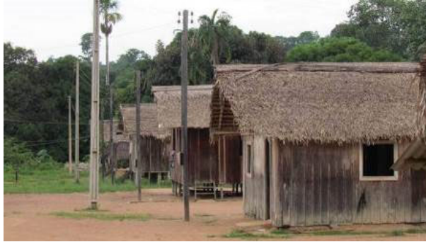
Foto 01: A estrutura das casas e das diversas construções dos Tenharim é geralmente feita de esteios e tábuas, com cobertura de palhas. Detalhe para residências na aldeia Mafuí (07/11/14).
