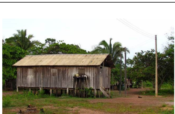
Foto 16: Detalhe de residência na aldeia Taboka (09/11/14), construída com tábuas serradas e com cobertura de palha de babaçu ( Attalea speciosa ).
