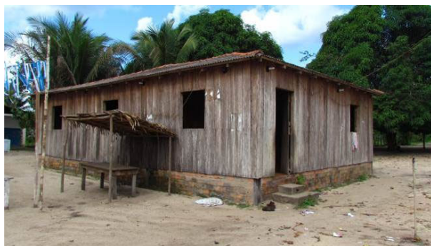
Foto 25: Detalhe de residência na aldeia Kampinhu-hu (11/11/14), construída com tábuas serradas e com cobertura de telhas de fibrocimento onduladas. Observar o alicerce feito com tijolos e cimento.
