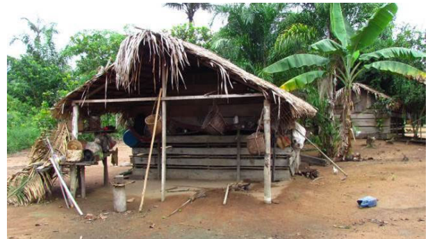
Foto 10: Detalhe de barracão na aldeia Kastanheira (06/11/14), com cobertura de palha de babaçu ( Attalea speciosa ).
