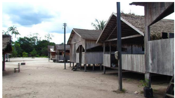
Foto 24: Detalhe de residências na aldeia Kampinhu-hu (11/11/14), construídas com tábuas serradas e com cobertura de palha de babaçu ( Attalea speciosa ) e telhas de fibrocimento onduladas.
