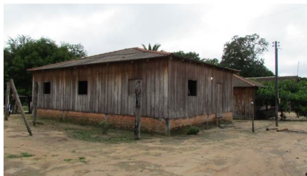
Foto 44: Detalhe de residência na aldeia Marmelos 2 (17/11/14), construída com tábuas serradas e com cobertura de telhas de fibrocimento onduladas. Observar o alicerce feito com tijolos e cimento.
