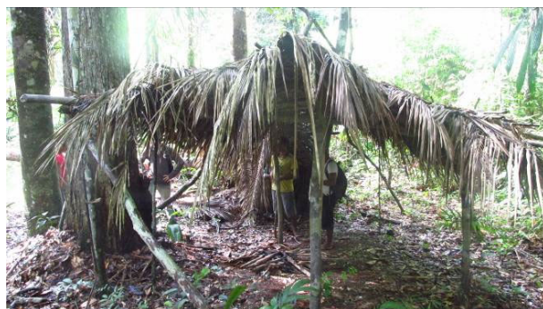
Foto 58: Detalhe de tapiri localizado nos arredores da aldeia Taboka. Por ser edificação simples, a cobertura é feita com no máximo 3 camadas de palha braba ( ungatei ).
