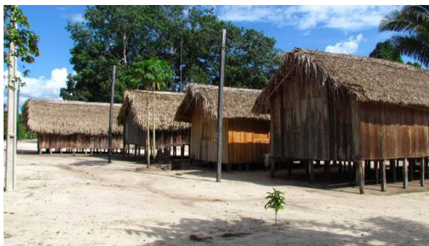
Foto 23: Detalhe de residências na aldeia Kampinhu-hu (11/11/14), construídas com tábuas serradas e com cobertura de palha de babaçu ( Attalea speciosa ).
