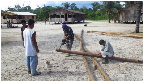
Foto 63: Atualmente, a madeira é serrada com auxílio de moto-serra (construção da casa de reunião – ongá , na aldeia Kampinhu-hu, 12/11/2014).
