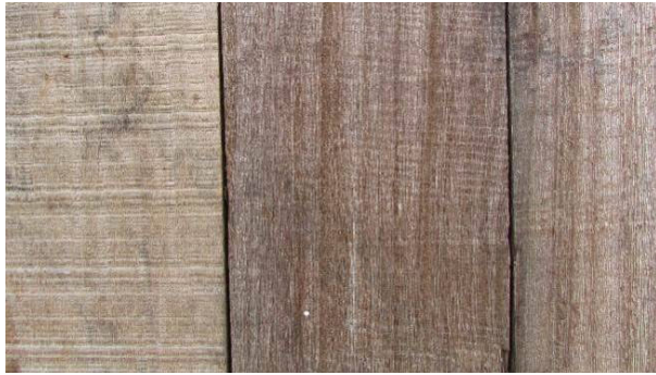
Foto 37: Detalhe de parede de casa feita com tábuas serradas de garapeira ( Apuleia cf. leiocarpa ).
