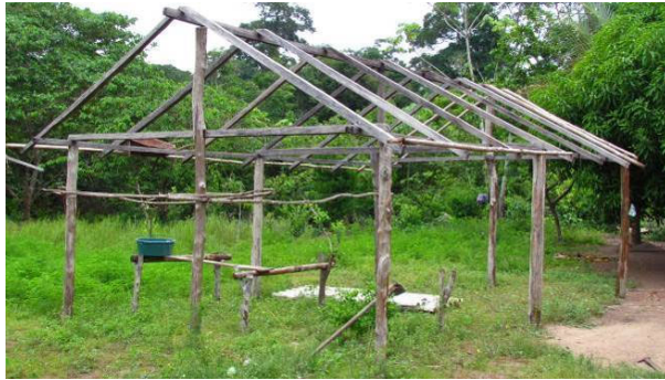
Foto 19: Detalhe de armação de residência na aldeia Taboka (09/11/14).
