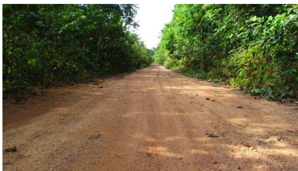
Foto 11: As exceções são as aldeias Karanaí e Jakuí, que se localizam nas margens da Rodovia do Estanho.
