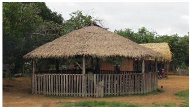
Foto 34: Detalhe de sala de reuniões na aldeia Bela Vista (15/11/14), construída com tábuas serradas e com cobertura de palha de babaçu ( Attalea speciosa ).
