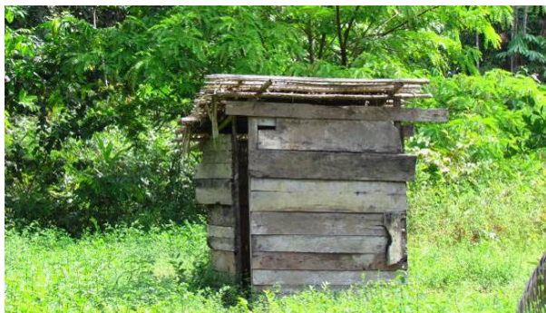
Foto 11: Detalhe de banheiro na aldeia Kastanheira (06/11/14), construído com tábuas serradas.
