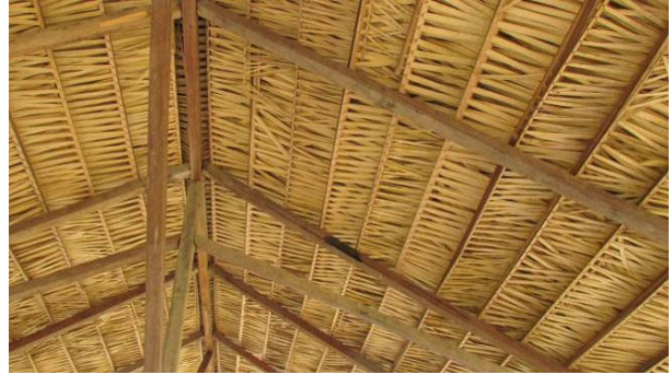
Foto 14: Detalhe da cobertura da sala de reuniões da aldeia Kastanheira (06/11/14), feita com ripas de maçaranduba ( Manilkara bidentata ) e ipê ( Tabebuia sp) e palha de babaçu ( Attalea speciosa ), presas com cipó-titica ( Heteropsis flexuosa ).
