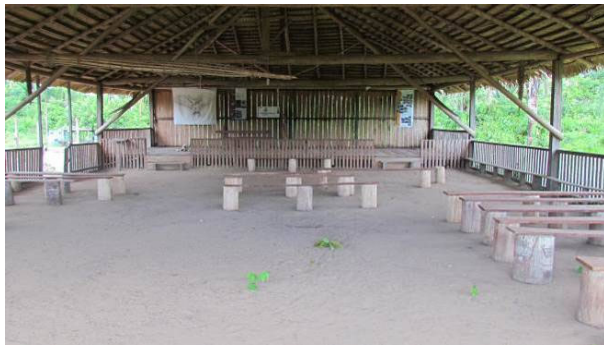
Foto 39: Detalhe da sala de reuniões da aldeia Marmelos 4 (12/11/14), construída com tábuas serradas e com cobertura de palha de babaçu ( Attalea speciosa ).
