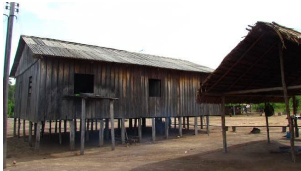
Foto 31: Detalhe de residência na aldeia Trakuá (13/11/14), construída com tábuas serradas e cobertura de telhas de fibrocimento ondulada.
