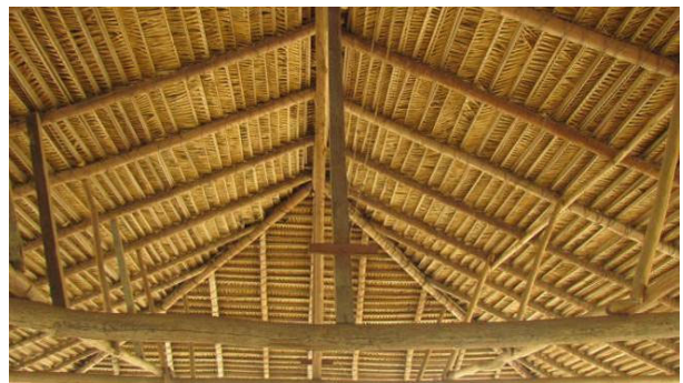
Foto 42: Detalhe da estrutura da cobertura da sala de reuniões da aldeia Marmelos 2 (17/11/14), feita com troncos de wyratinga ( Rubiaceae sp) e palha de babaçu ( Attalea speciosa ), presas com cipó-titica ( Heteropsis flexuosa ).
