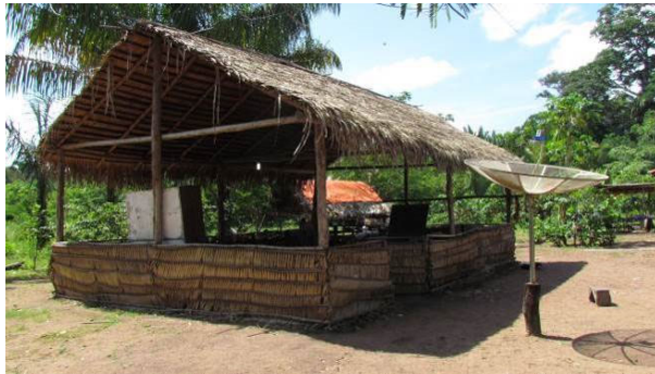
Foto 03: Detalhe da sala de reuniões da aldeia Mafuí (08/11/14), construída com esteios de acariquara ( Minquartia guianensis ) e palha de babaçu ( Attalea speciosa ).
