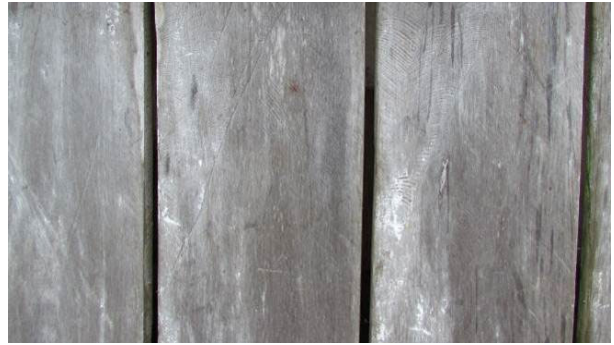
Foto 38: Detalhe de parede de casa feita com tábuas serradas de cedro ( Cedrela sp.).
