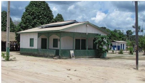
Foto 51: Detalhe de construção na aldeia Vila Nova (19/11/14), toda construída com tábuas serradas e com cobertura de telhas de fibrocimento onduladas.
