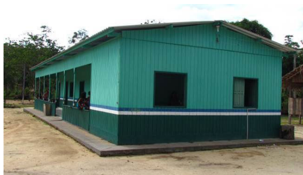
Foto 28: Detalhe de escola da aldeia Kampinhu-hu (12/11/14), construída com tábuas serradas e cobertura de telhas de fibrocimento ondulada.
