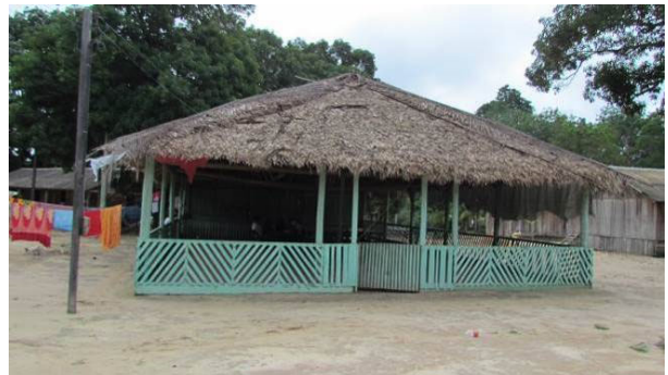
Foto 40: Detalhe da sala de reuniões da aldeia Marmelos 2 (17/11/14), construída com tábuas serradas e com cobertura de palha de babaçu ( Attalea speciosa ).
