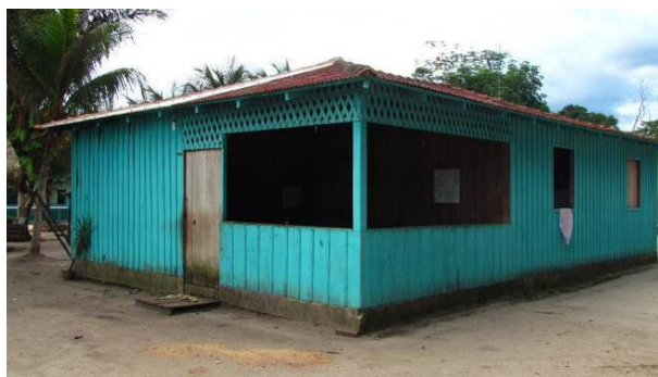
Foto 27: Detalhe de residência na aldeia Kampinhu-hu (12/11/14), construída com tábuas serradas e cobertura de telhas de fibrocimento ondulada.
