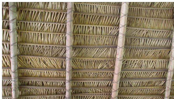
Foto 56: A pindowa é utilizada nas construções mais importantes, como as casas de reunião ( ongá ), como esta da aldeia Marmelos 4. Para aumentar a durabilidade da cobertura, são colocadas até 6 camadas de pindowa sobrepostas.
