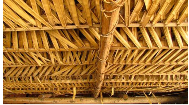
Foto 08: Detalhe da amarração feita na cobertura de casa na aldeia Jakuí (05/11/14), com cipó-titica ( Heteropsis flexuosa ), que prende as palhas de babaçu ( Attalea speciosa ) nas estipes da palmeira.
